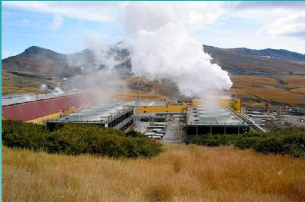
Геотермическая электростанция – тепловая электростанция, преобразующая внутреннее тепло Земли в электрическую энергию. Источники глубинного тепла - радиоактивные превращения, химические реакции и другие процессы, происходящие в земной коре температура пород с глубиной растет и на уровне 2000-3000 м от поверхности Земли превышает 100°С.
