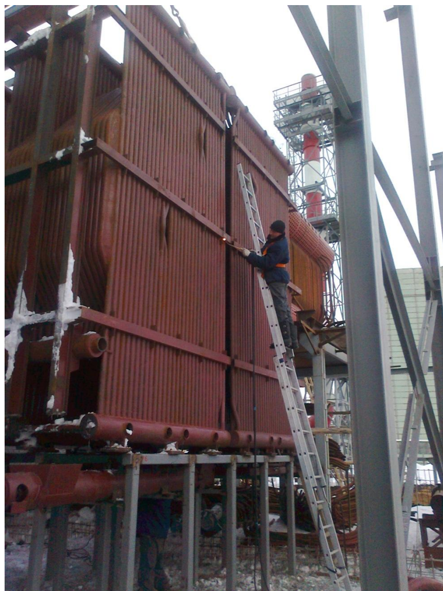
Монтаж, стыковка топочных блоков котла Е-25-24РТО
