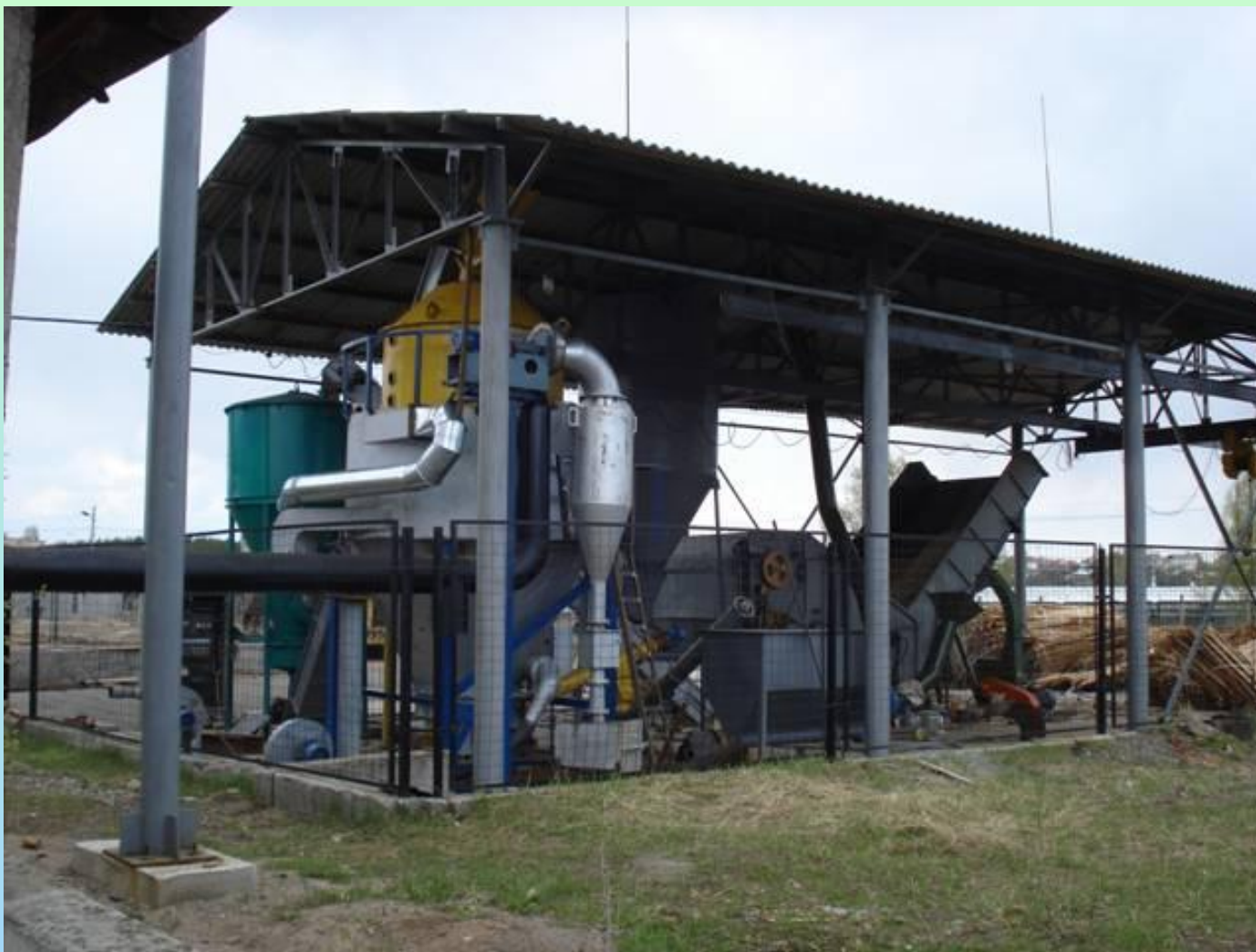
Монтаж комплекса на базе газогенератора ГТП-3,0 в г. Малин
