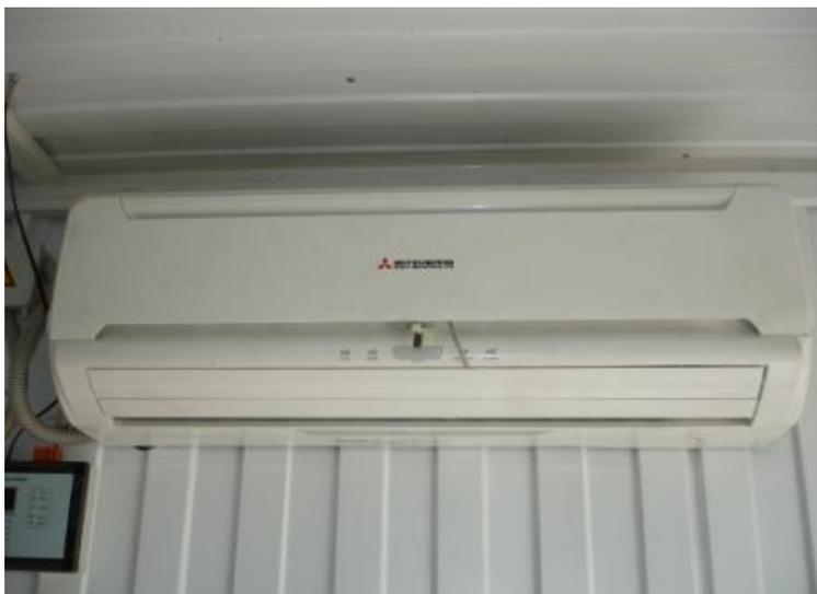
**В связевом отсеке устанавливается кондиционер с внутренней системой климат-контроля, а также с функциями очистки и подпитки воздуха.**
