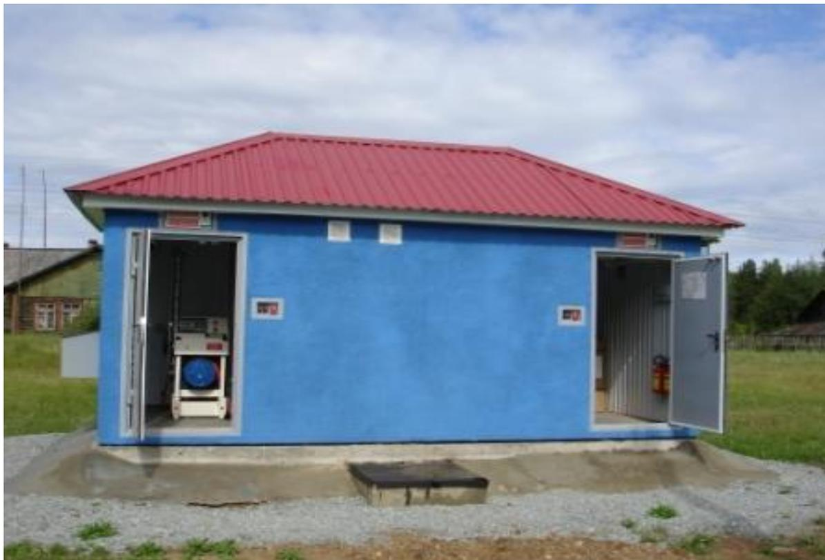
На базе модуля связи можно быстро организовать на отдаленной станции или в любом другом месте автономное помещение для размещения телекоммуникационного оборудования и оборудования связи технологического назначения.
