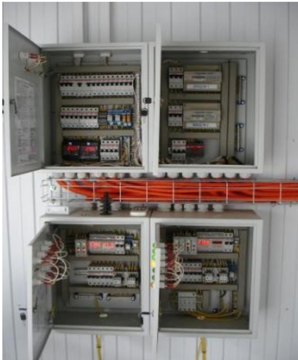
Охранная и пожарная сигнализация включает прибор приемно-контрольный и управления пожарный, прибор охранно-пожарной сигнализации и управления.
