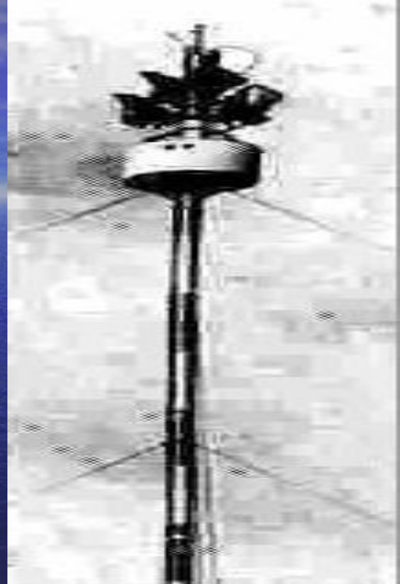
Станция линии радиорелейной связи
