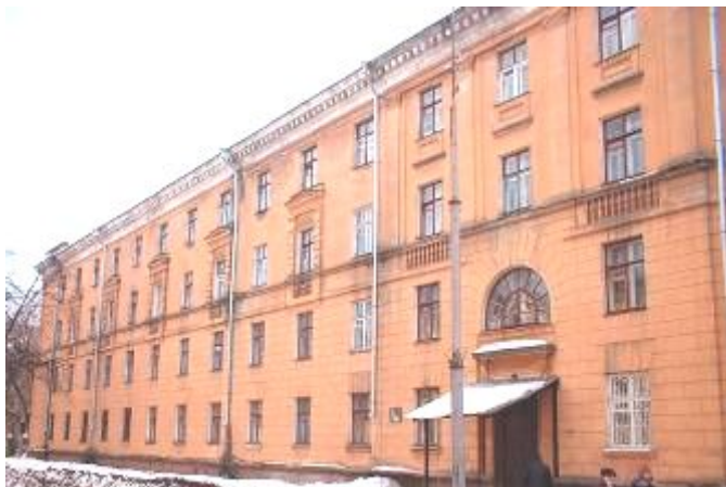
Общежитие №3 (ул. Садовая, 12)
