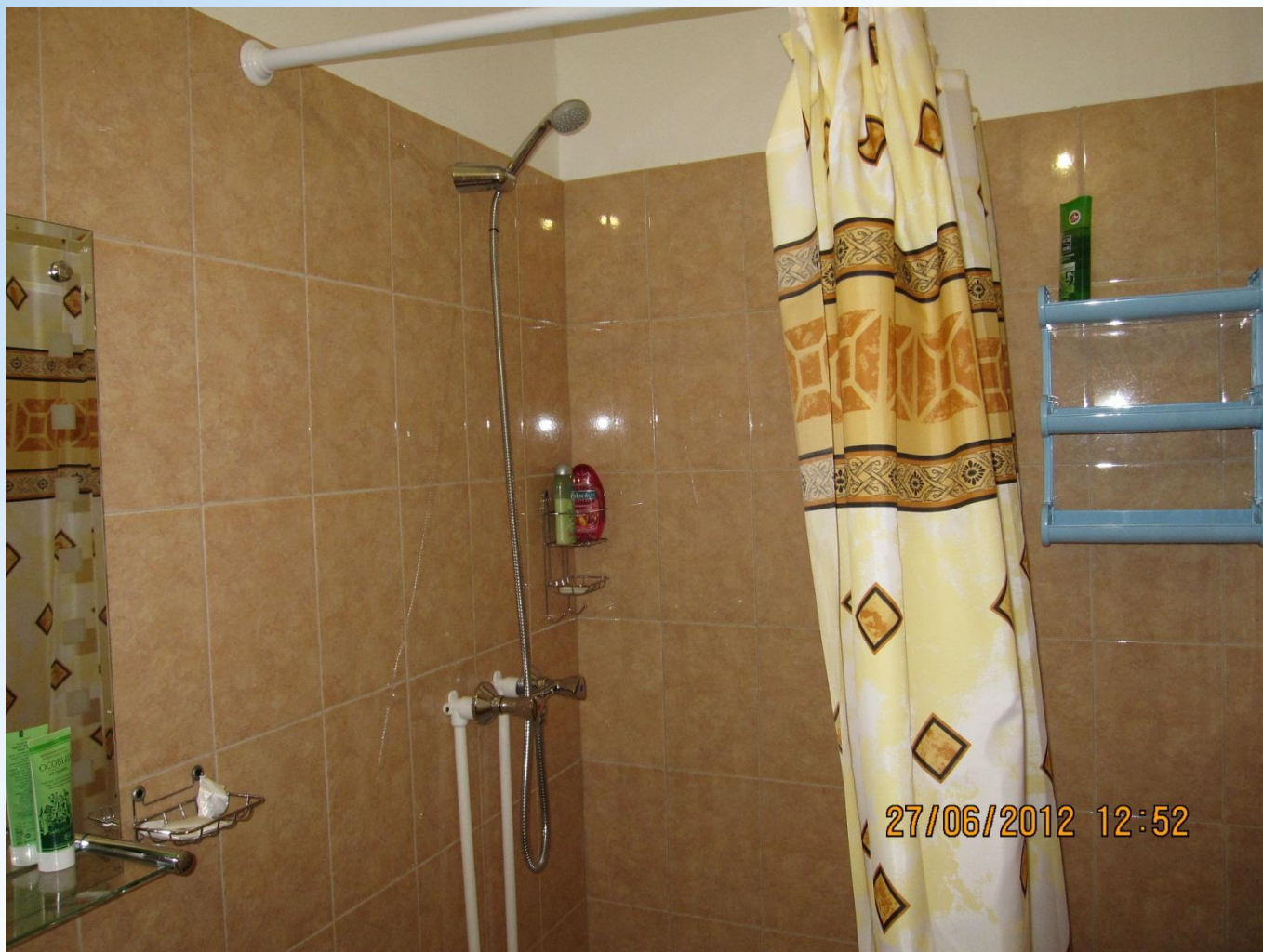
Ремонт сан.узла УЖК, Лиговский пр. 275.
