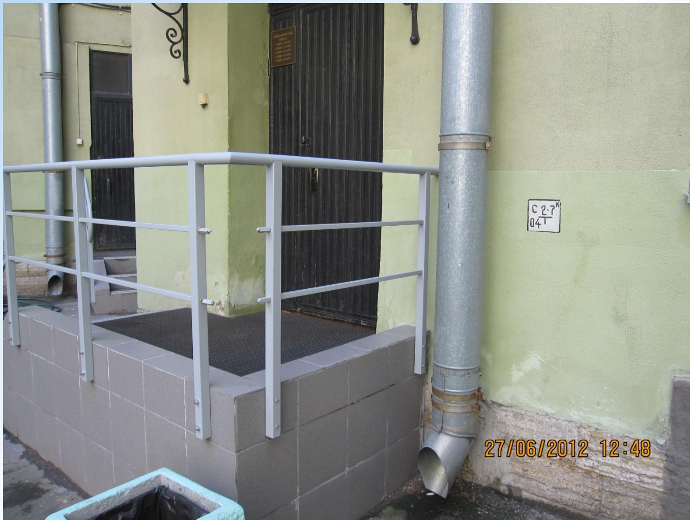
Ремонт входной лестницы УЖК, Лиговский пр. 275.
