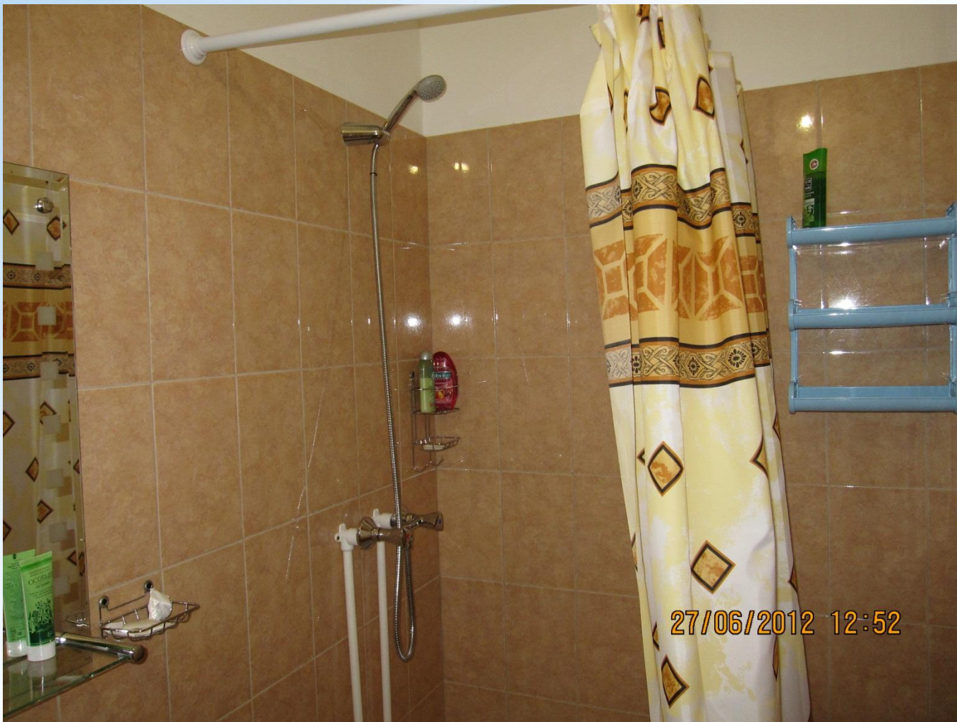
Ремонт сан.узла УЖК, Лиговский пр. 275.
