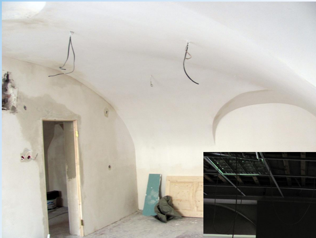
Ремонт Криминалистической лаборатории, корпус 20
