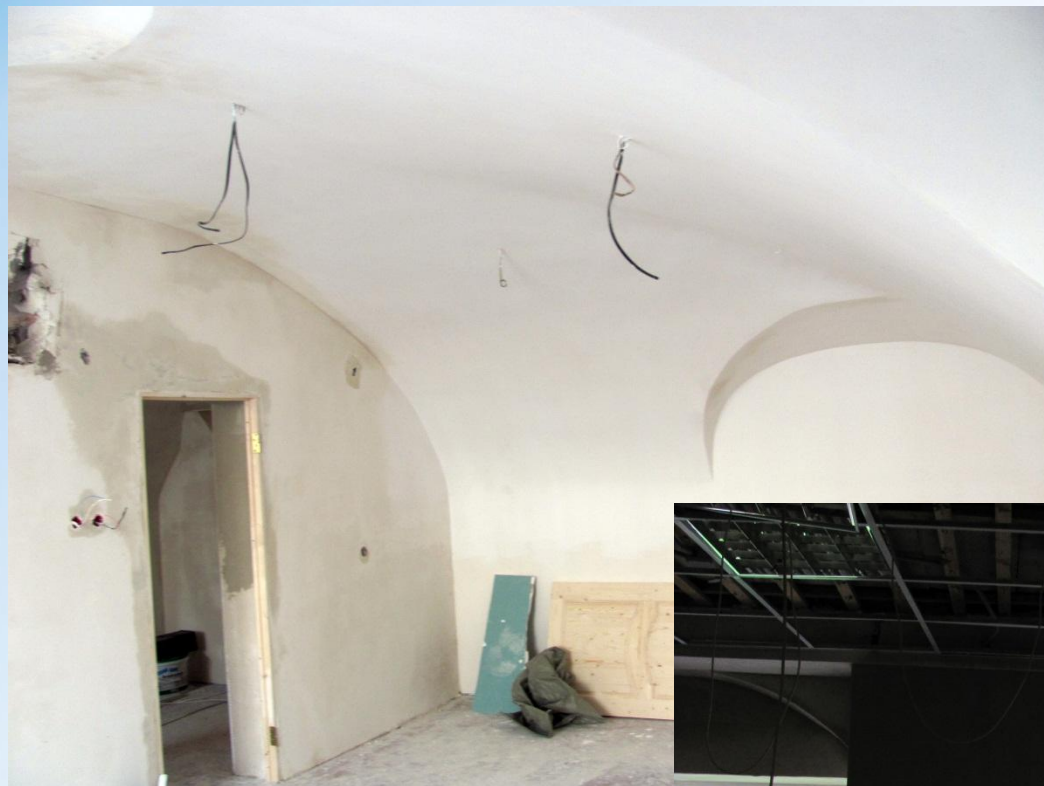
Ремонт Криминалистической лаборатории, корпус 20
