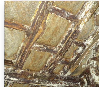
Коррозионные поражения углеродистой и низколегированной стали
