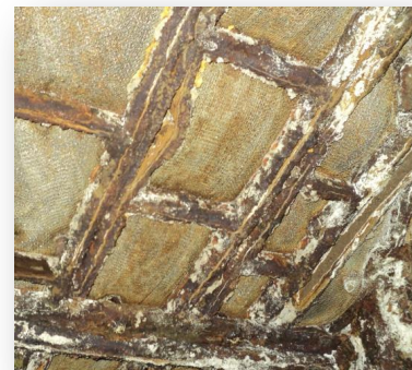
Коррозионные поражения углеродистой и низколегированной стали
