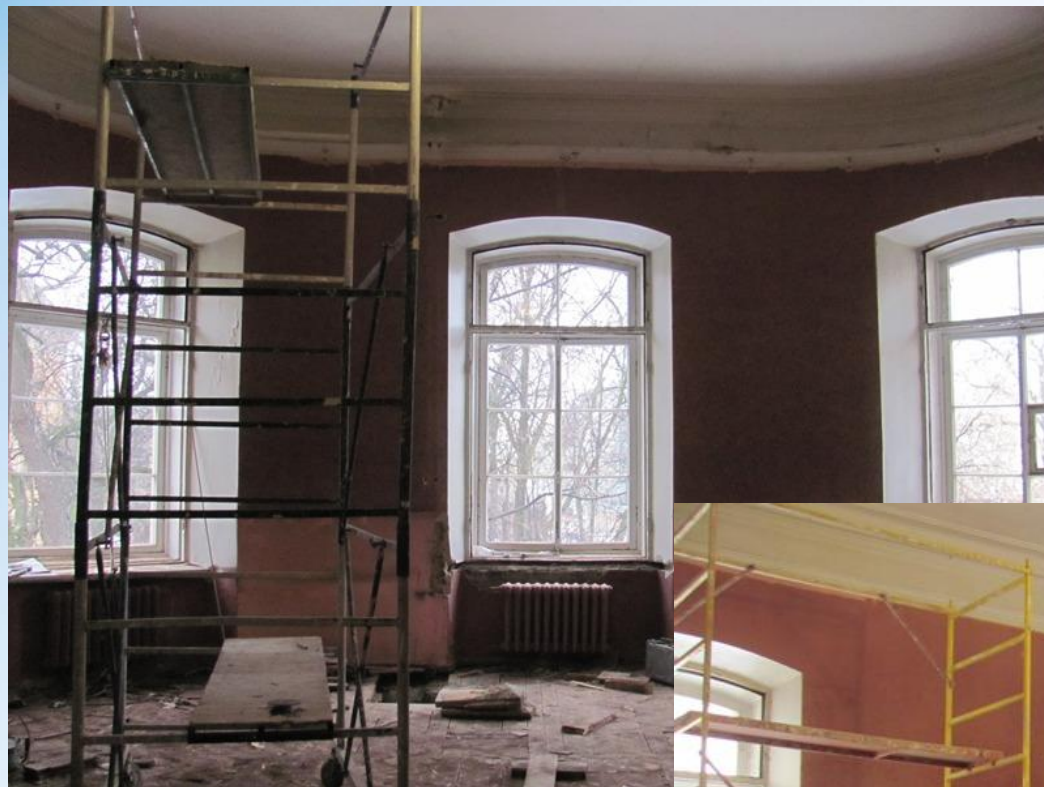
Ремонт "Павловского зала" корпус 5
