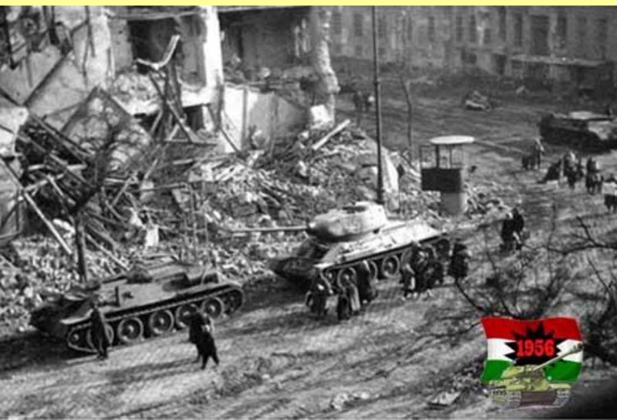
Разрушения в Будапеште.
