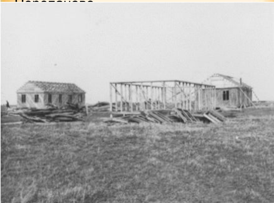
Строительство поселка Целинный
