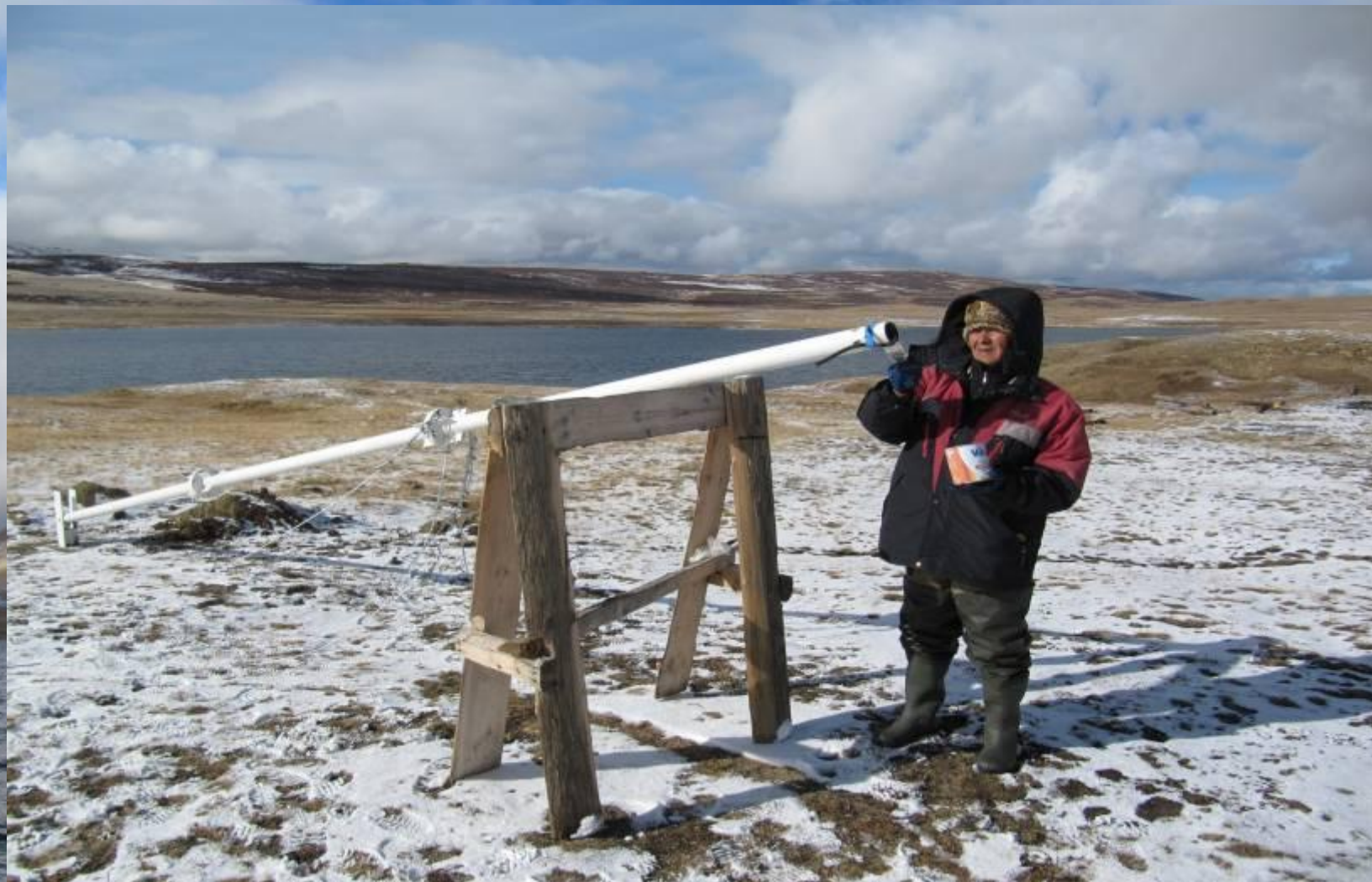
Покраска мачты высотой 6 м.
