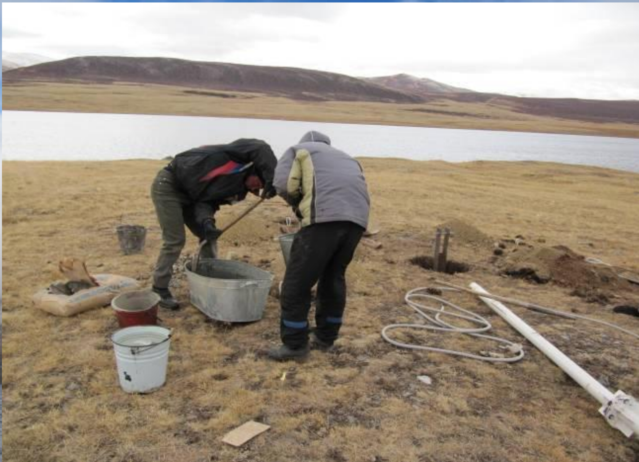
Работа по установке основания мачты для ветрогенератора
