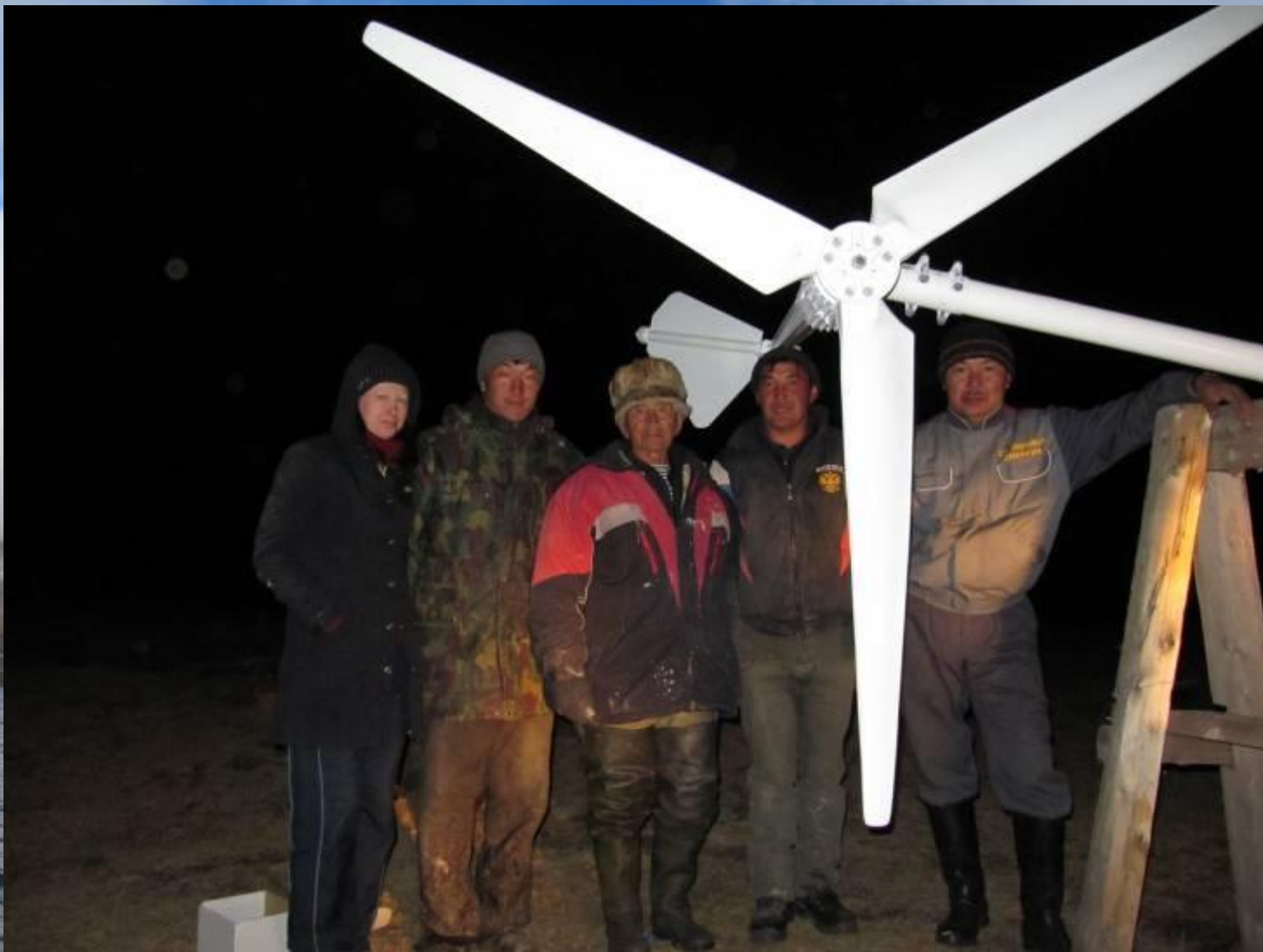
Установка ветроагрегата на мачту.
