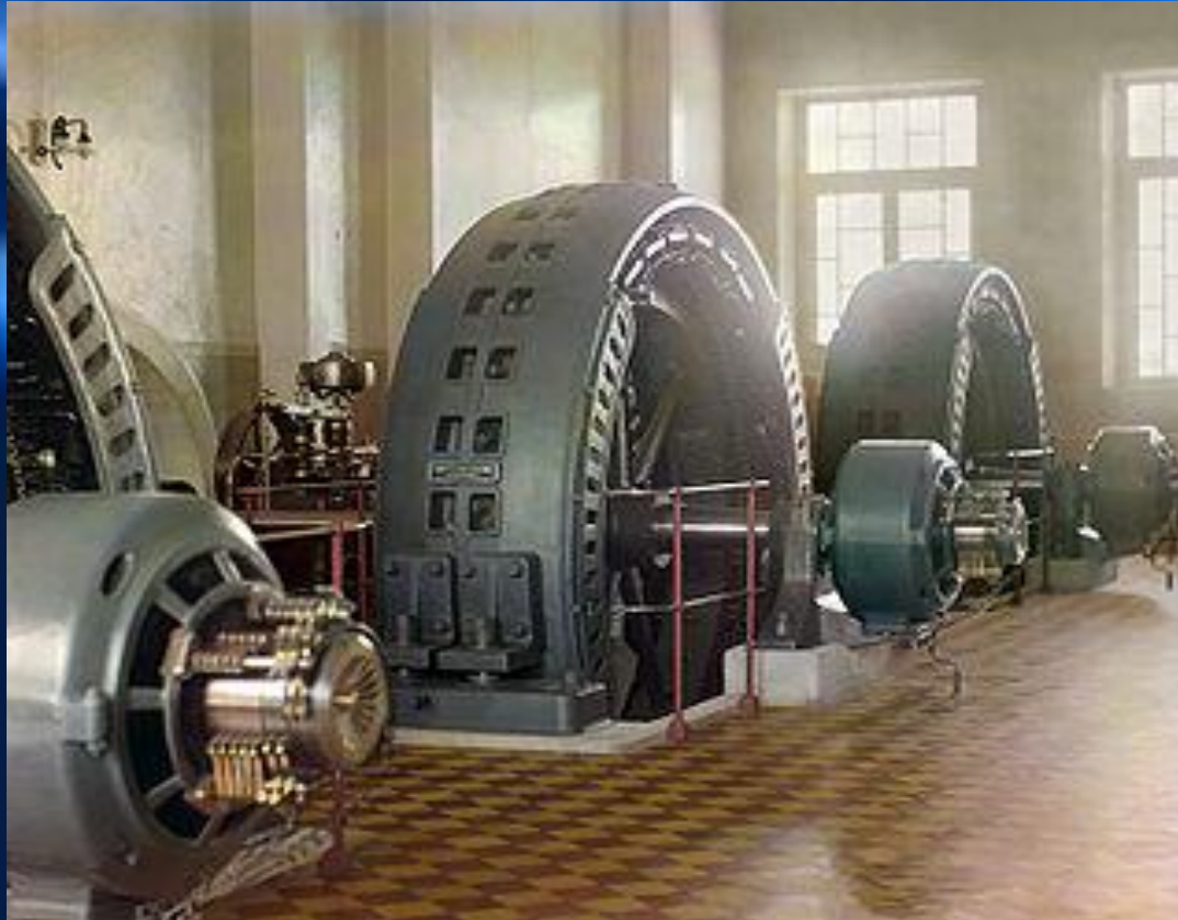
Генератор переменного тока раннего 20-го века сделанный в Будапеште
