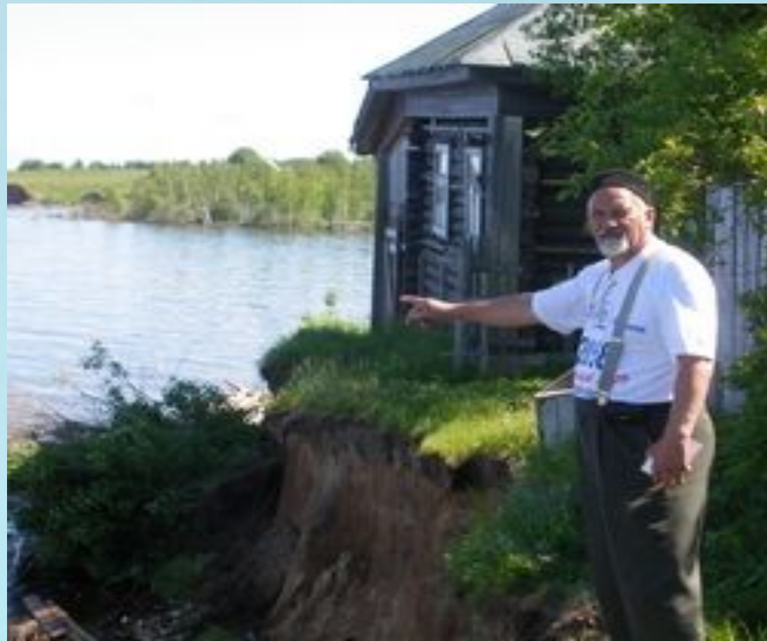
Размывание берегов Камского водохранилища.
