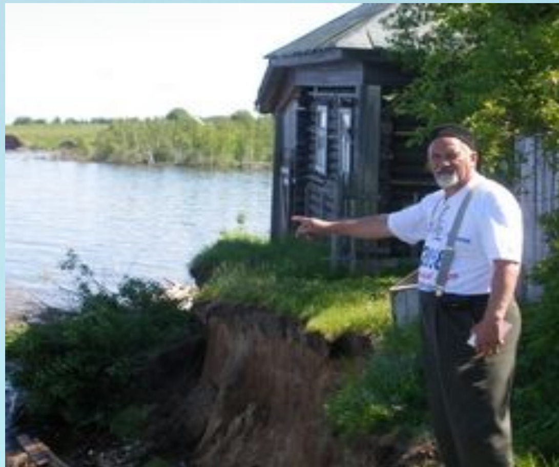
Размывание берегов Камского водохранилища.
