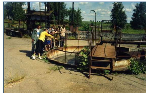
Екскурсія на Жовтоводські очисні споруди
