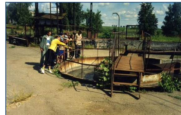
Екскурсія на Жовтоводські очисні споруди
