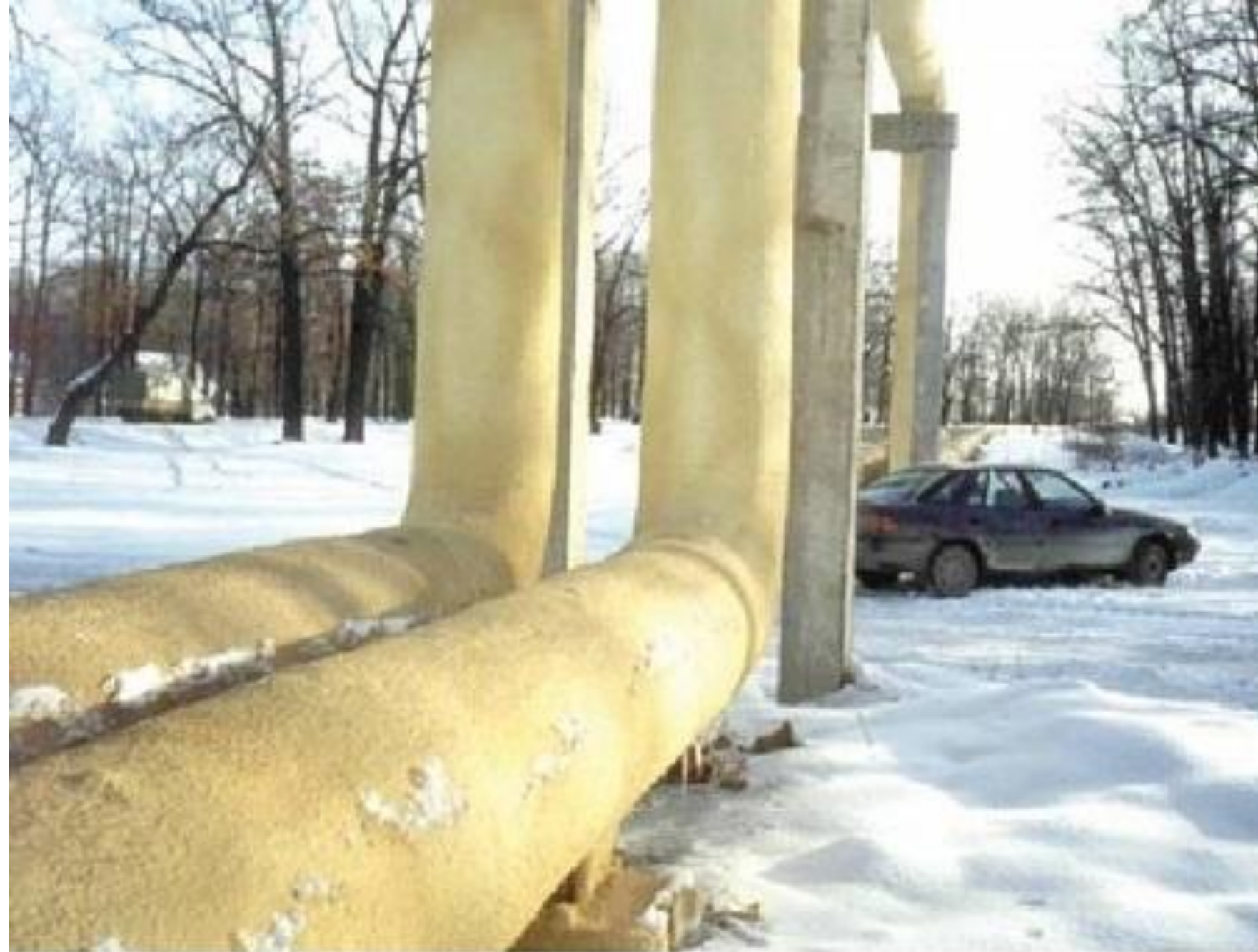
Теплоизоляция тепловых сетей
