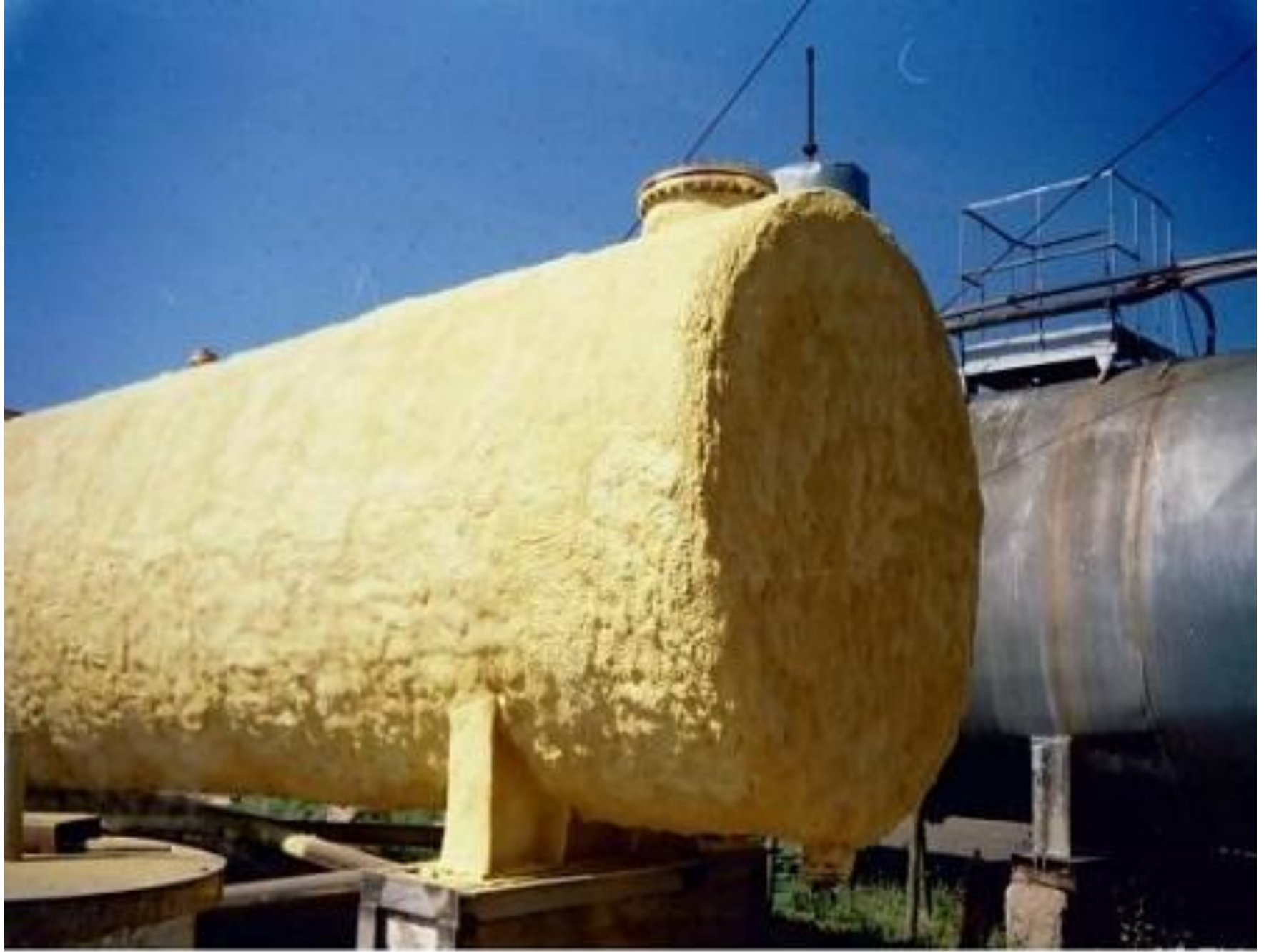
Теплоизоляция цистерны
