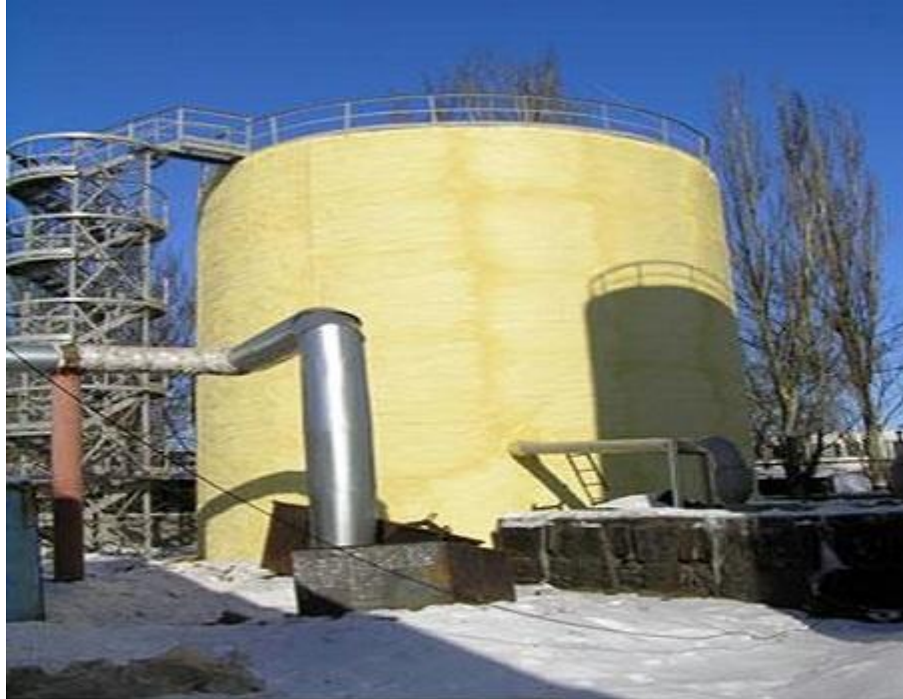
Теплоизоляция емкостей
