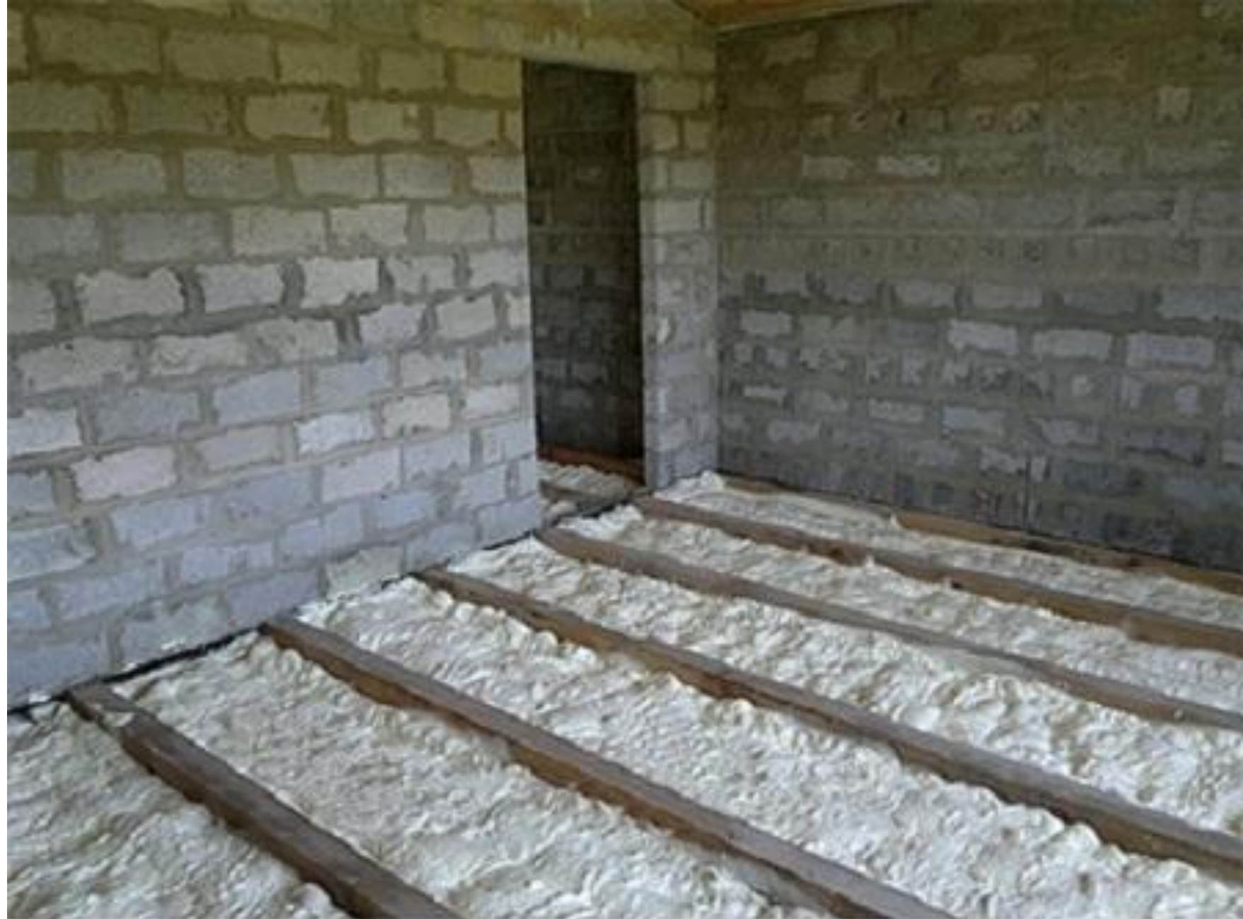
Теплоизоляция пола
