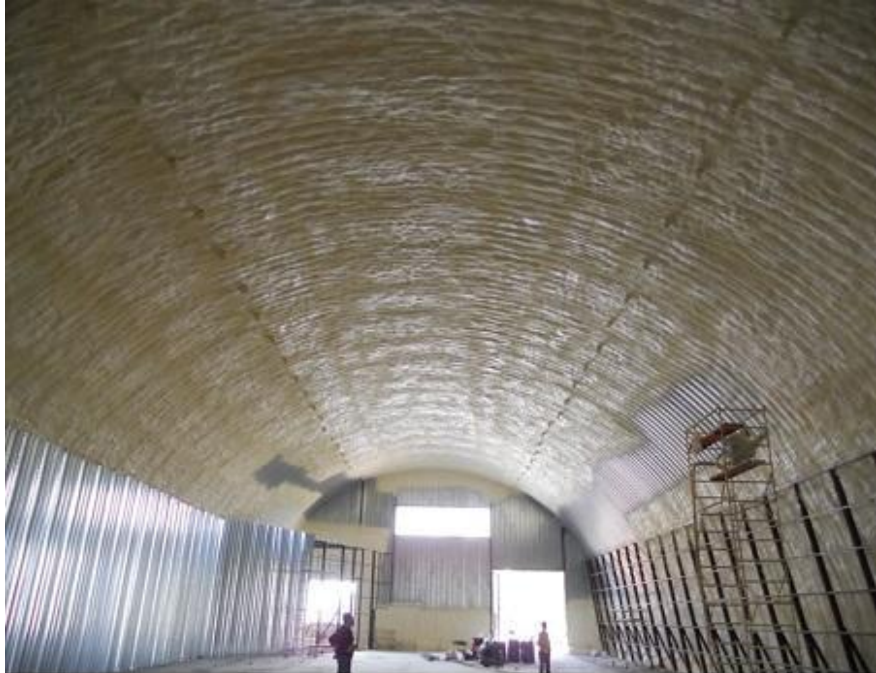
Утепление пенополиуретаном ангара
