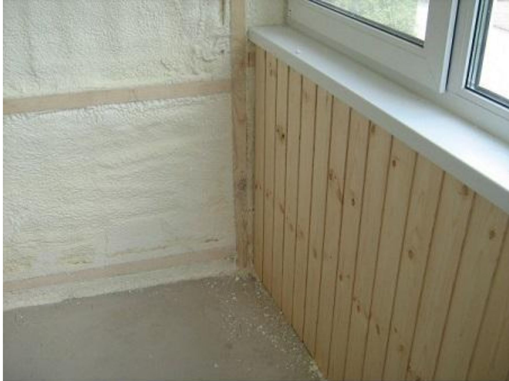
Внутренняя теплоизоляция лоджии в квартире
