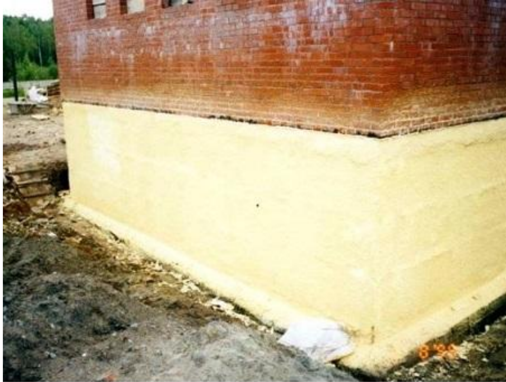
Тепло - гидроизоляция фундамента
