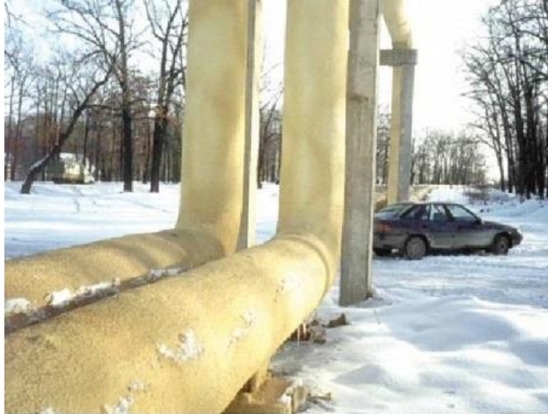
Теплоизоляция тепловых сетей
