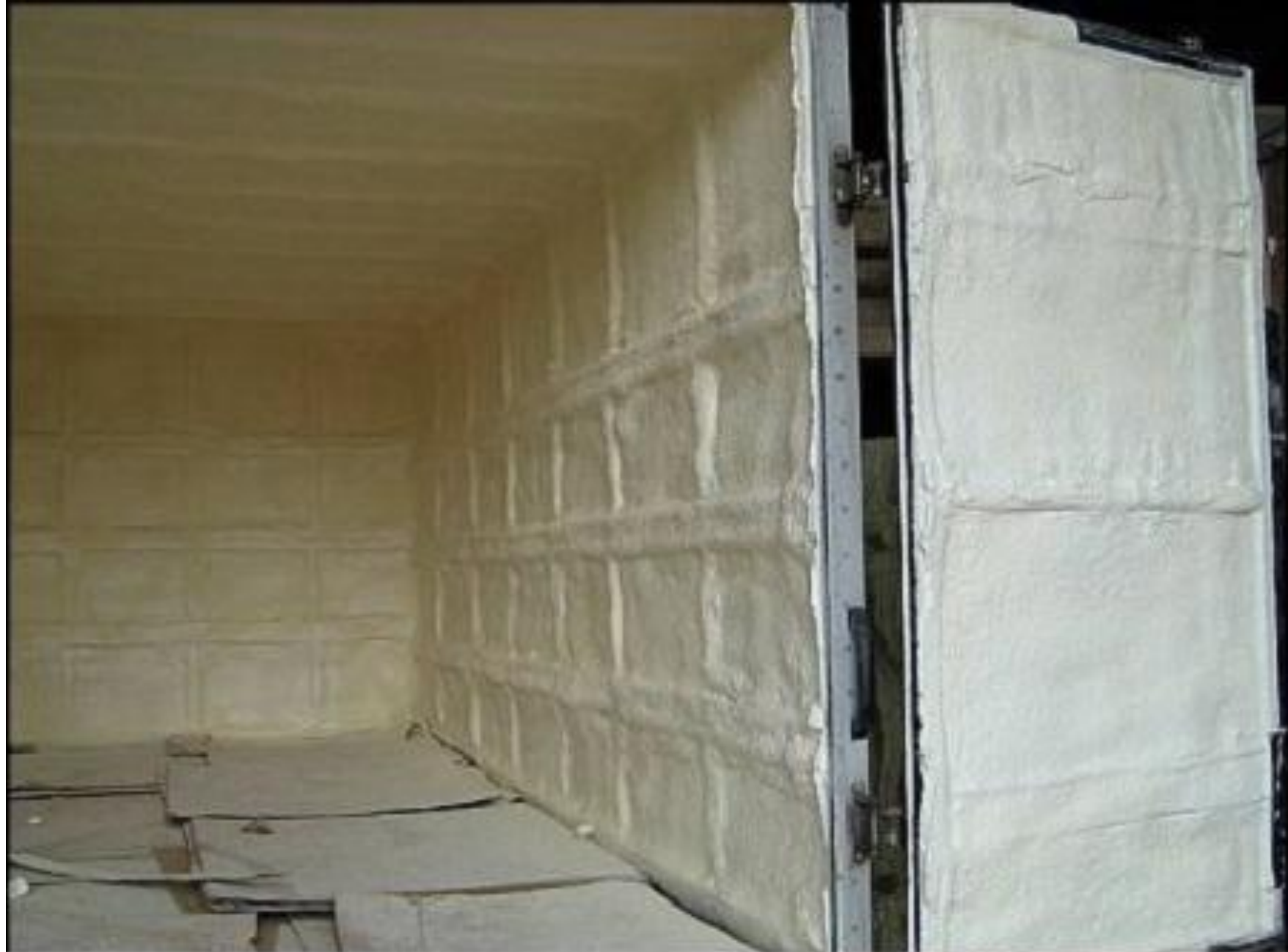
Теплоизоляция холодильной установки изнутри
