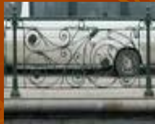
Решетка Ново-Конюшенного моста
