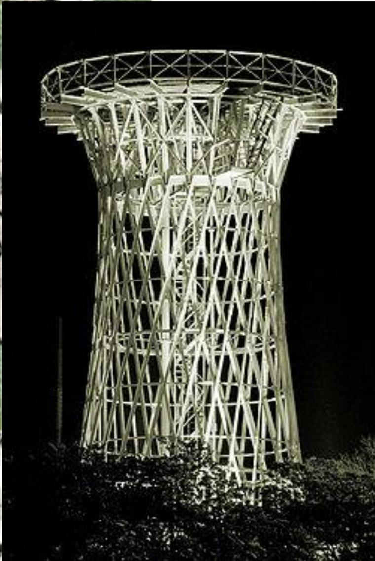
Водонапорная башня системы В. Г. Шухова построена в 1928-30 гг. Одна из первых в мире гиперболоидных конструкций и одна из семи сохранившихся башен системы инженера Шухова.
