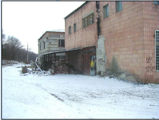
Здание УЦ до ремонта
