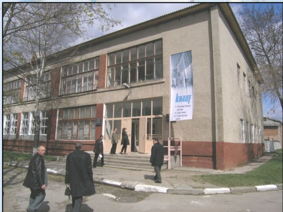
Здание ВПУ №7 – РЦ
