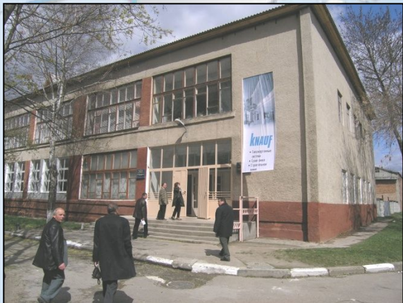
Здание ВПУ №7 – РЦ
