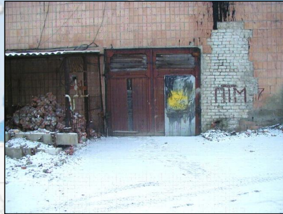
Здание УЦ до ремонта
