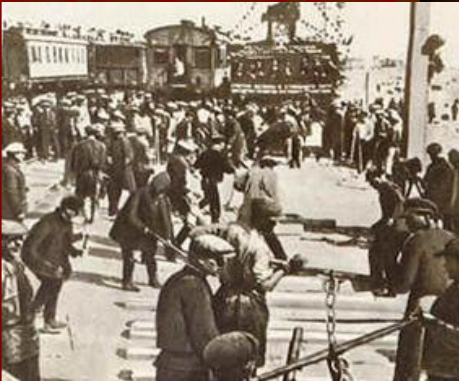
Укладка последних шпал на Турксибе. 1930 г.
