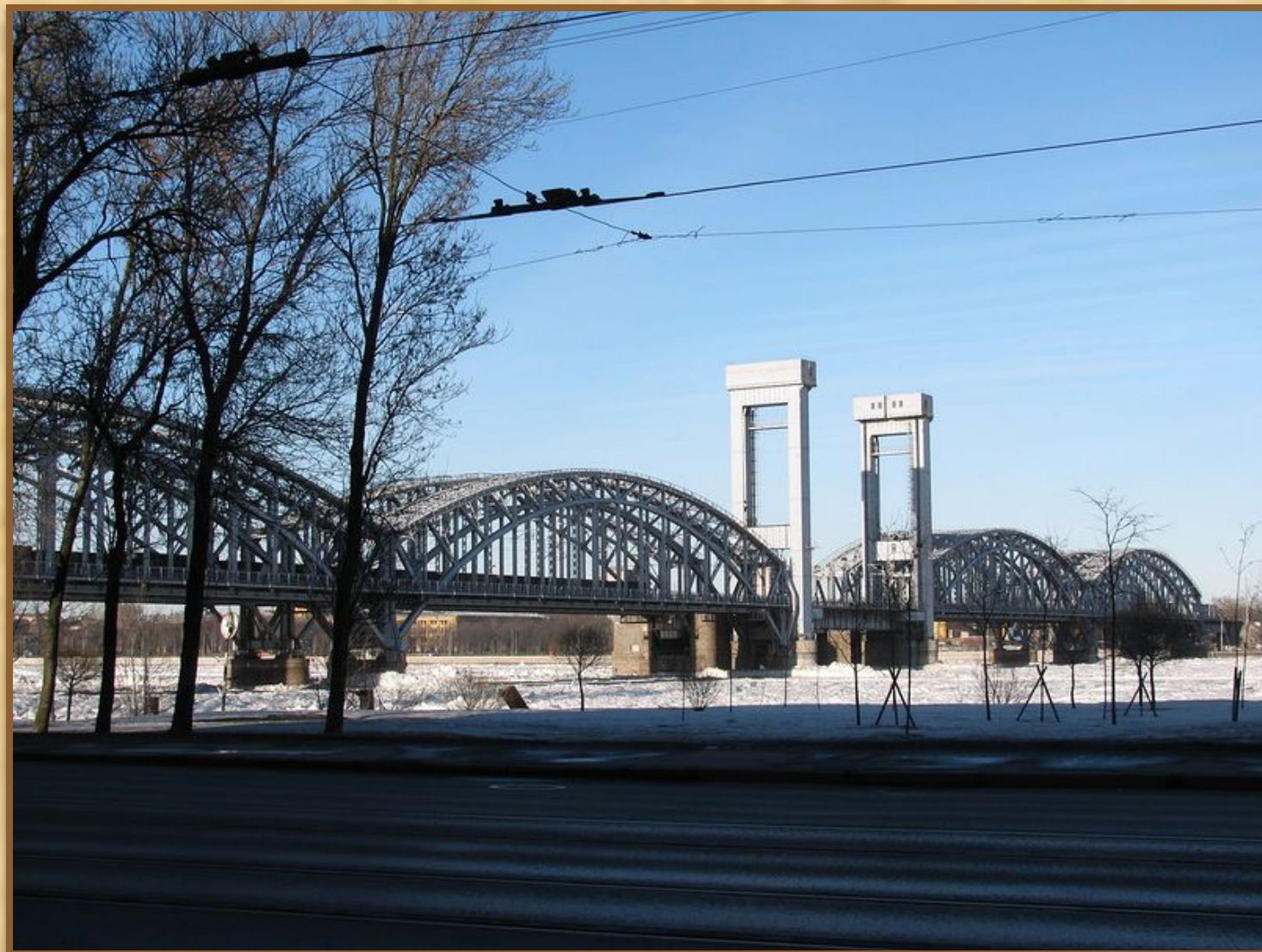
Финляндский железнодорожный мост
