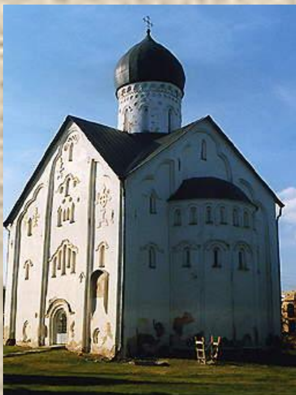
Спаса на Ильине улице, 1374г.
