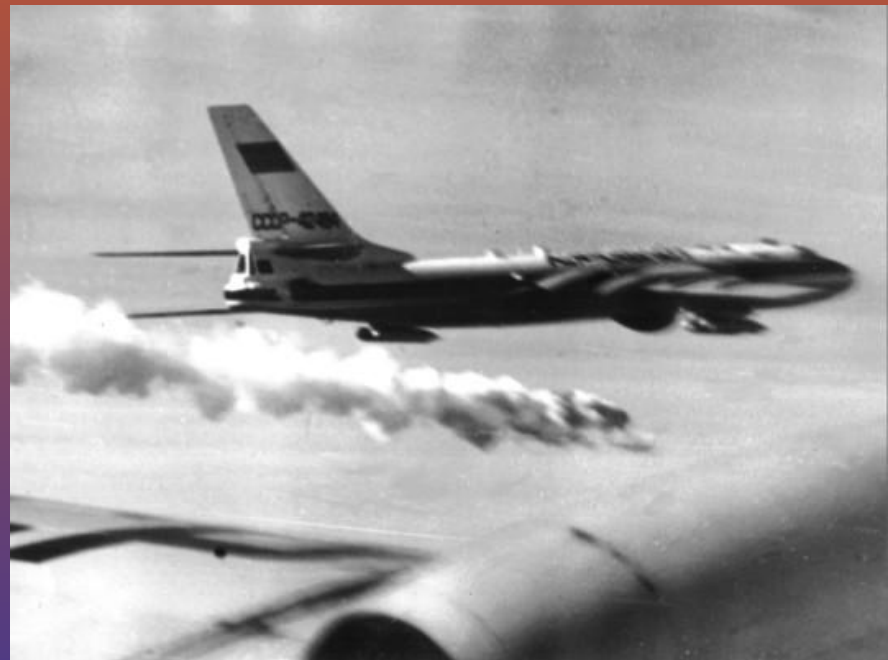
Самолет ТУ-16 "Циклон"- метеолаборатория. Сброс цемента над 4-ым реактором.
