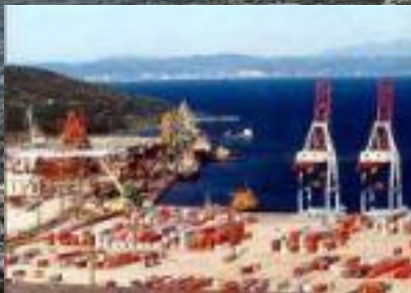
Контейнерный терминал Восточного порта
