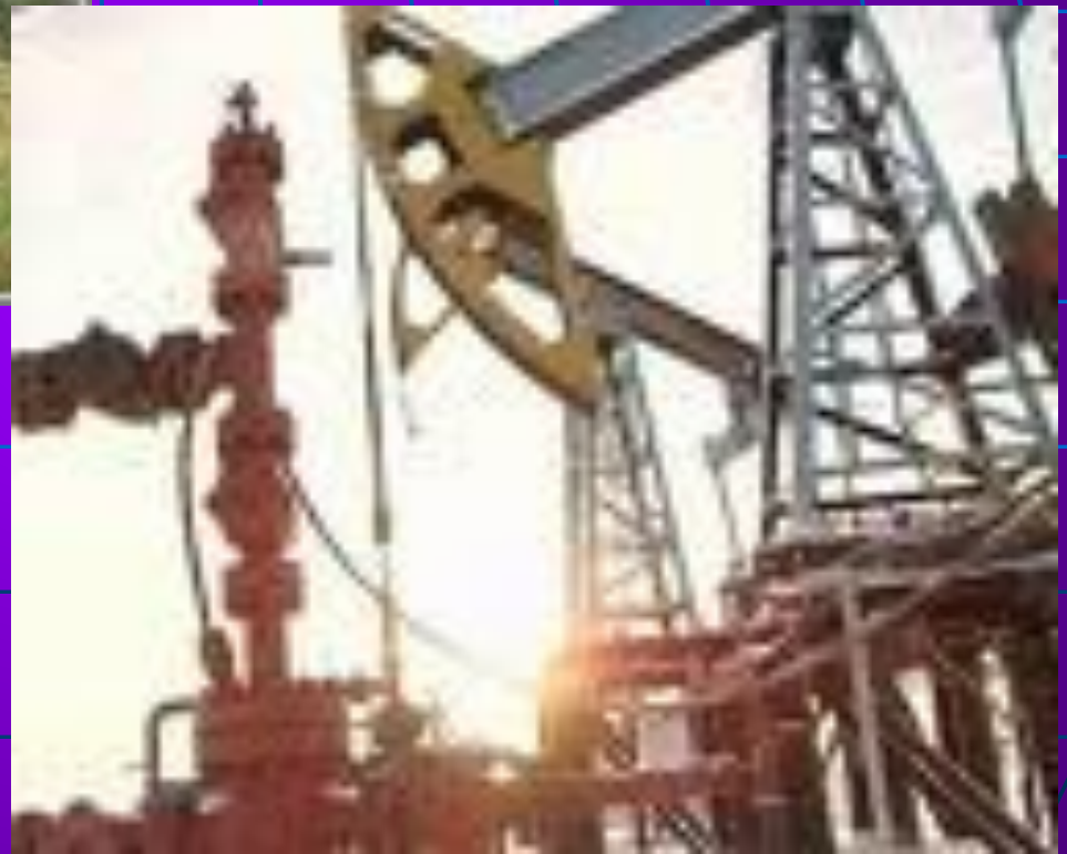
Станок – качалка нефти
