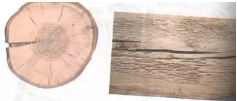
Рис. 12. Трещины древесины при несоблюдении правил сушки
