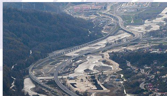
Совмещенная автомобильная и железная дорога Адлер - Альпика-Сервис
