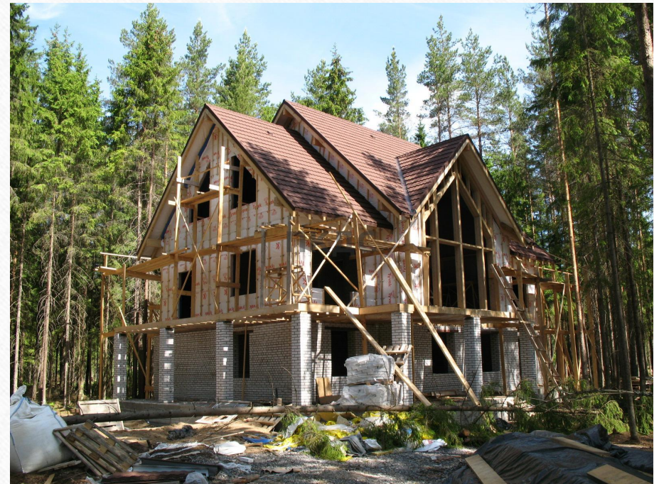
Рис. 28 Процесс строительства коттеджа
