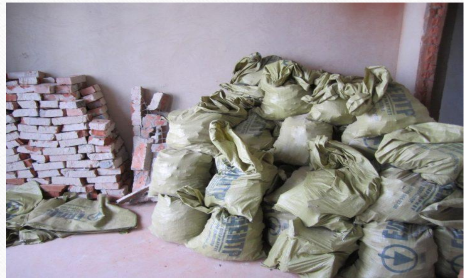
Рис. 34 Упаковка строительного мусора
