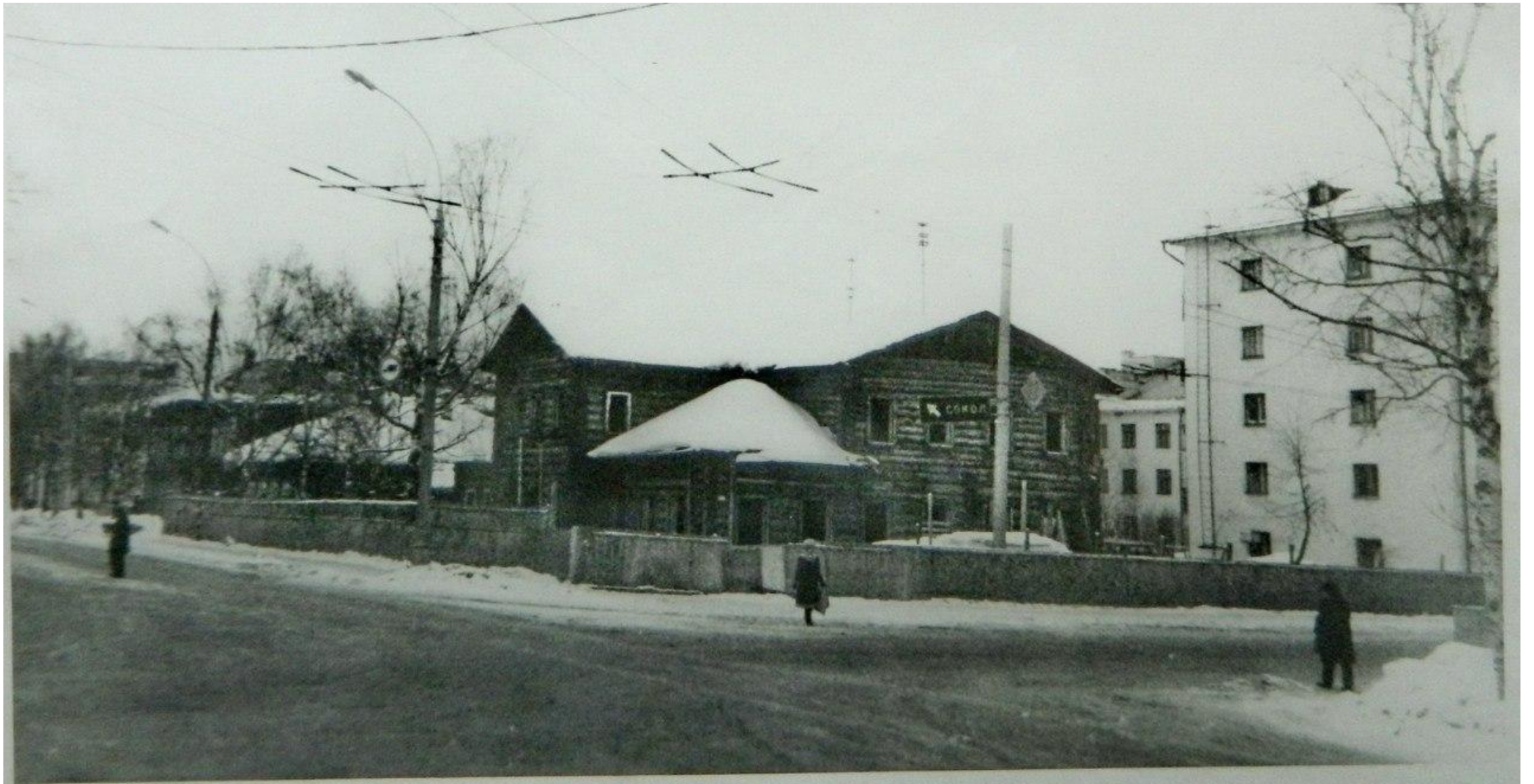
Реконструкция дома в 80-е годы
