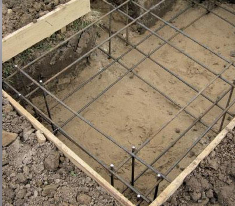
**Свайный фундамент** с армированным железобетонным ростверком. Фундамент данного типа изготавливается из буронабивных свай, которые объединяются в единую конструкцию посредством ростверка (специальной балки). Традиционно считают, что свайный фундамент представляет собой более экономичное решение по сравнению ленточным.
