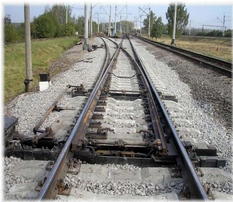
Рис 10.2 Обыкновенный стрелочный перевод
