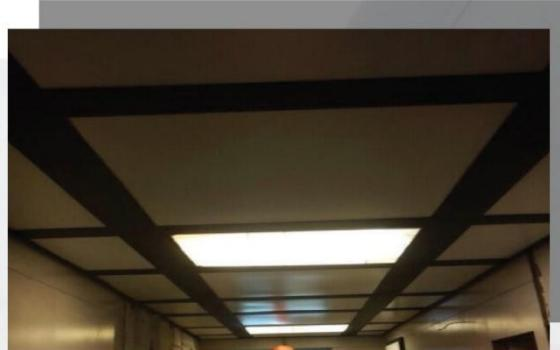
«BANDRASTER»— ЭТО ШИРОКАЯ СИСТЕМА ПОВЫШЕННОЙ ЖЕСТКОСТИ, которая производится из алюминия толщиной 0,7-1,2 мм.
