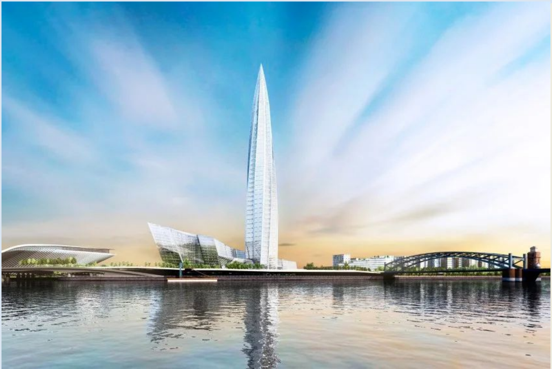
Лахта центр Приморский район
