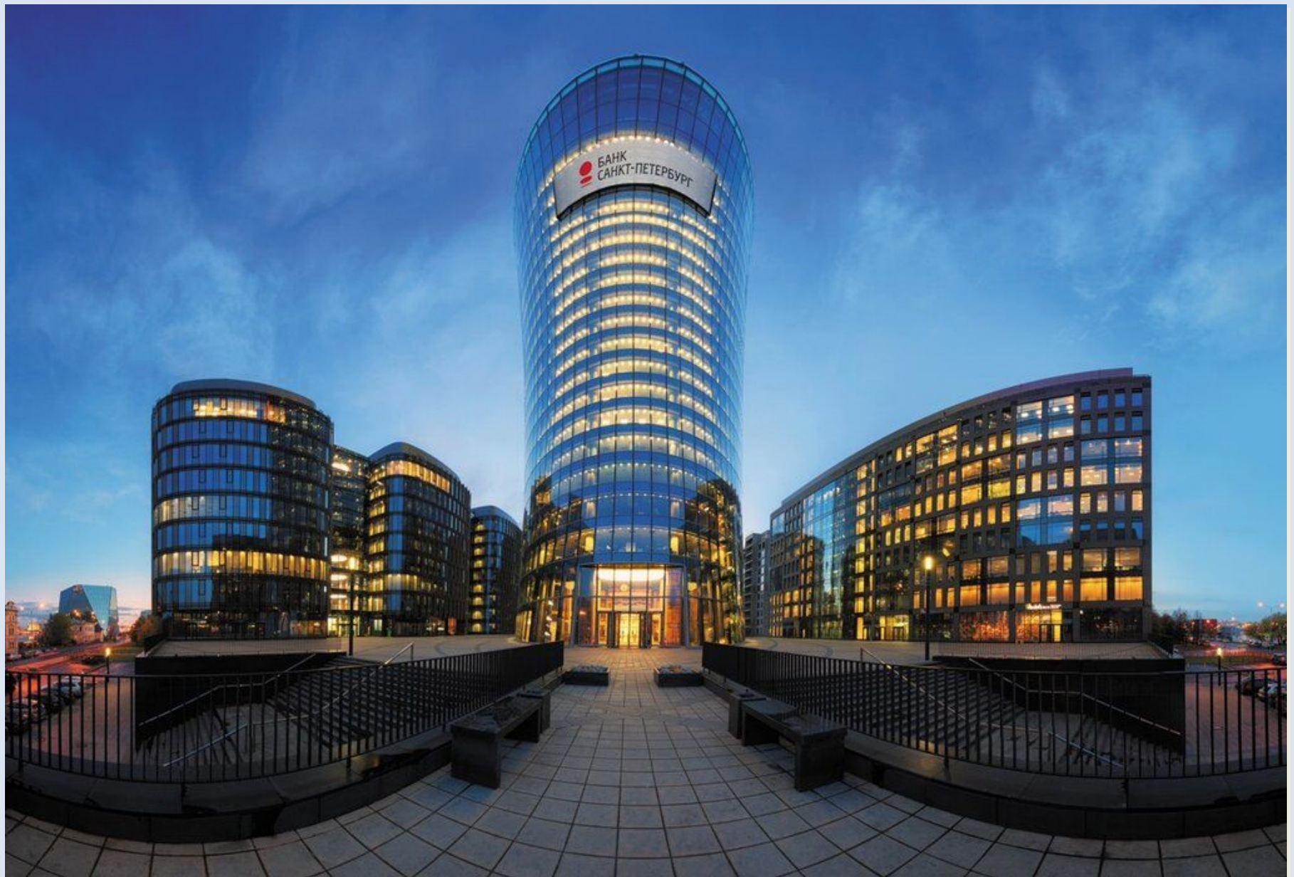
Банк «Санкт-Петербург» Малоохтинский проспект 64
