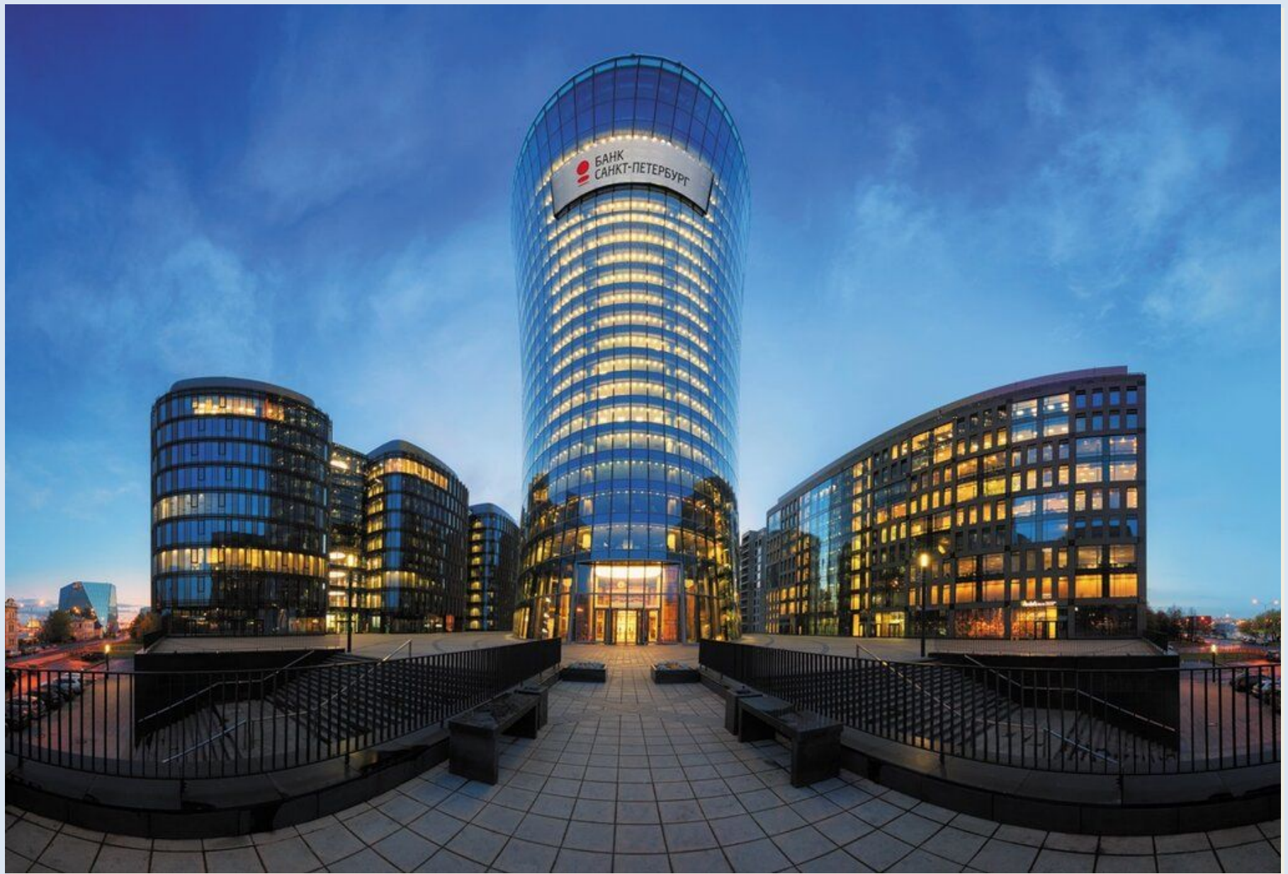
Банк «Санкт-Петербург» Малоохтинский проспект 64
