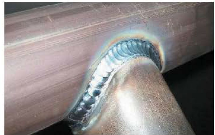
Рис. 2.10. Соединение труб электродуговой сваркой
