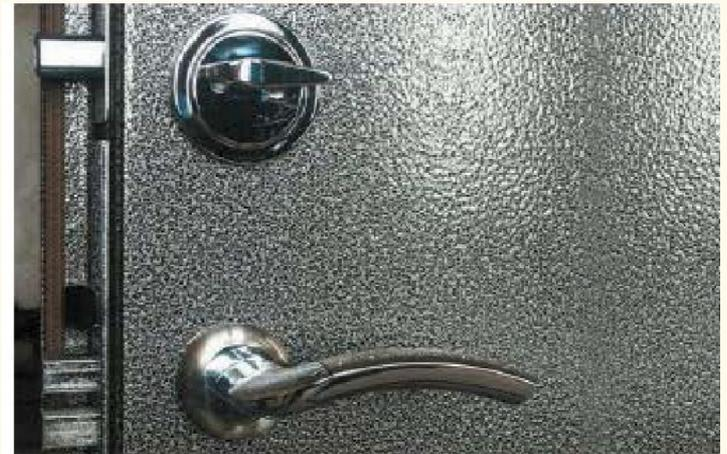
*Рис. 2.9.* Фрагмент металлической двери с порошковым напылением
