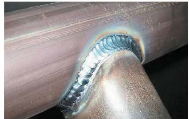
Рис. 2.10. Соединение труб электродуговой сваркой
