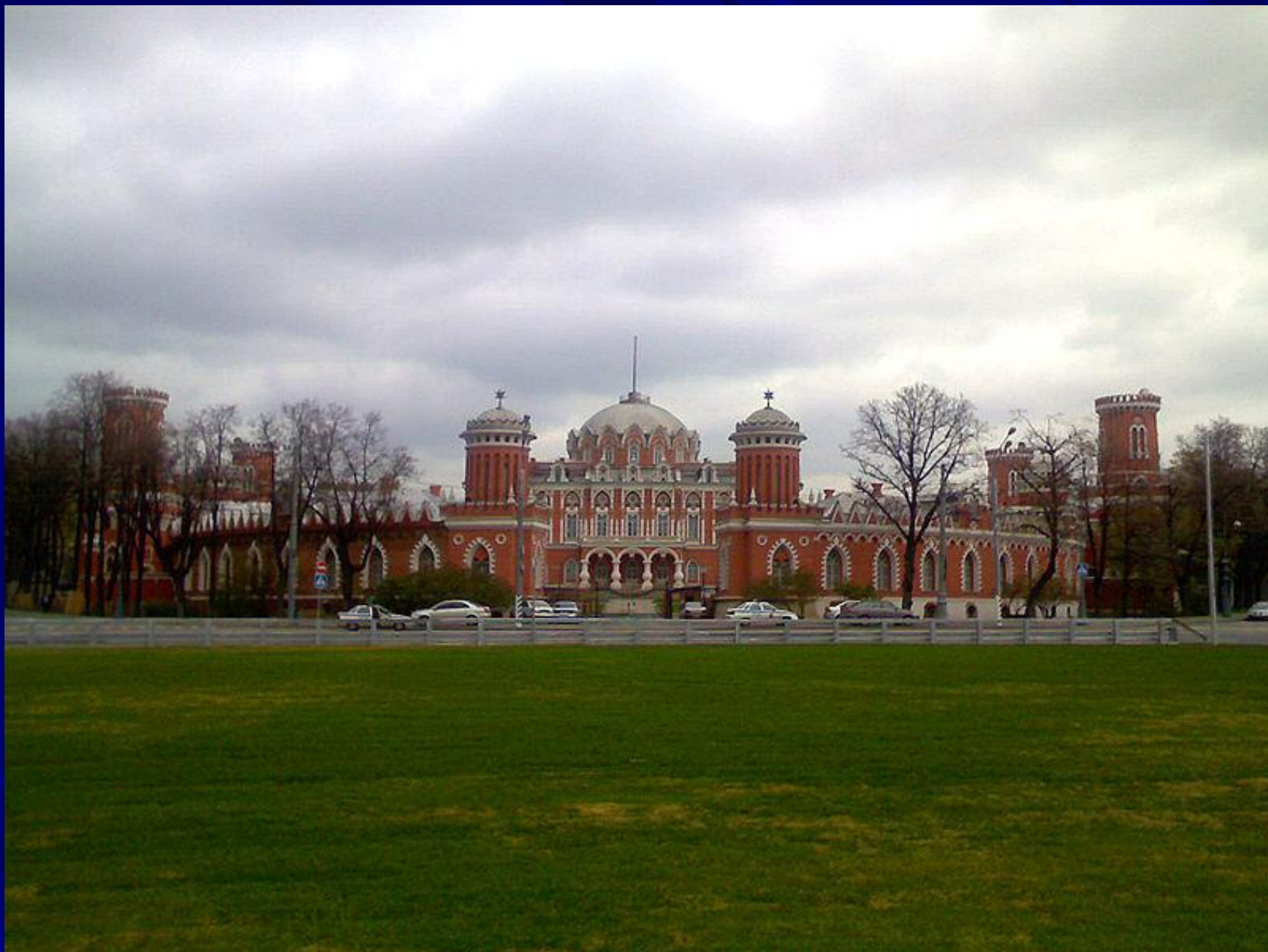
Путевой дворец Архитектор М.Казаков
