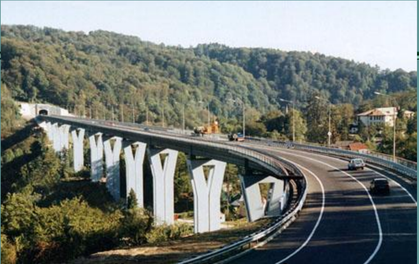
Мост через р. Мацесту в г. Сочи
