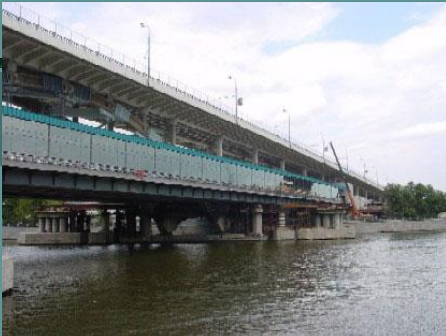
Реконструкция Лужниковского метромоста
