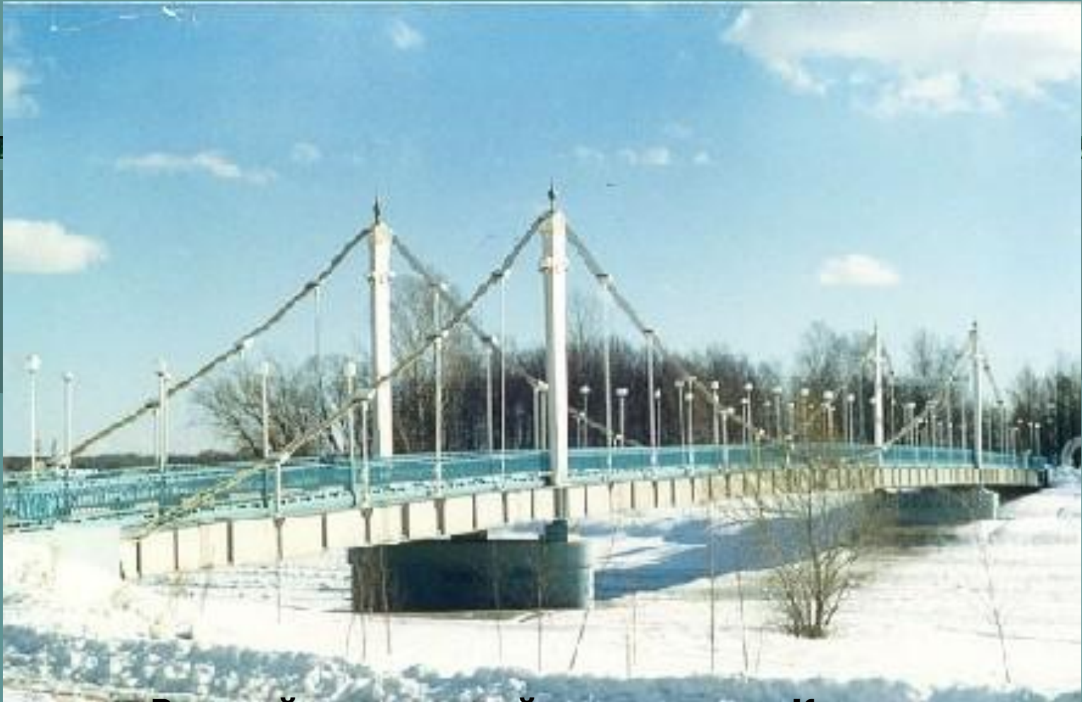
Висячий пешеходный мост через р. Которосль Год постройки: 1999 г.
