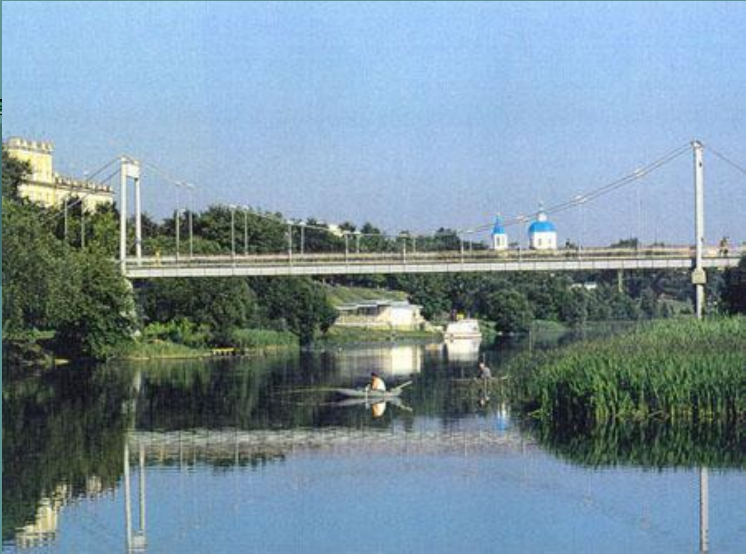
Мост через р. Цну в Мичуринске .
