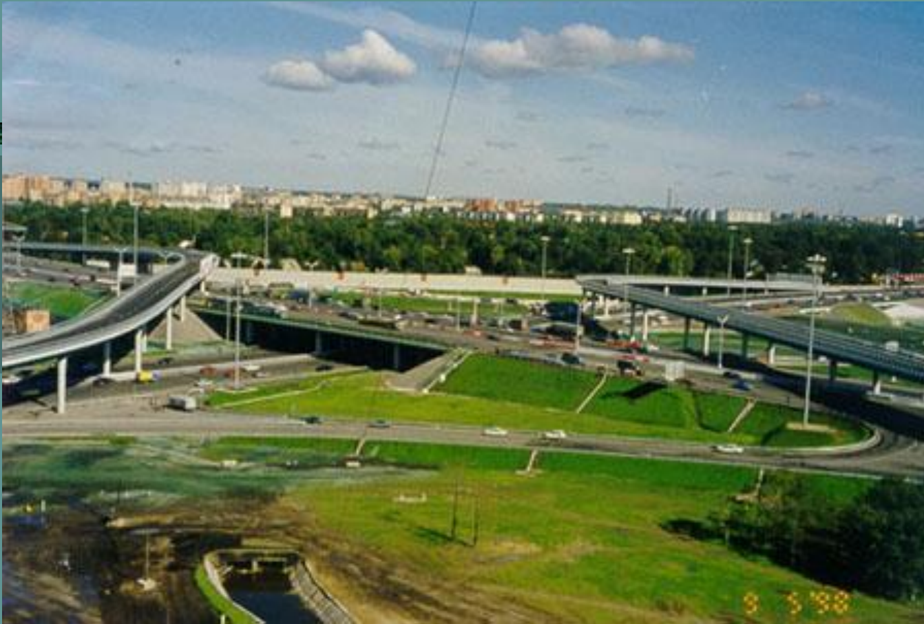
Развязка на пересечении Ярославского шоссе с МКАД Год постройки: 1998 г.
