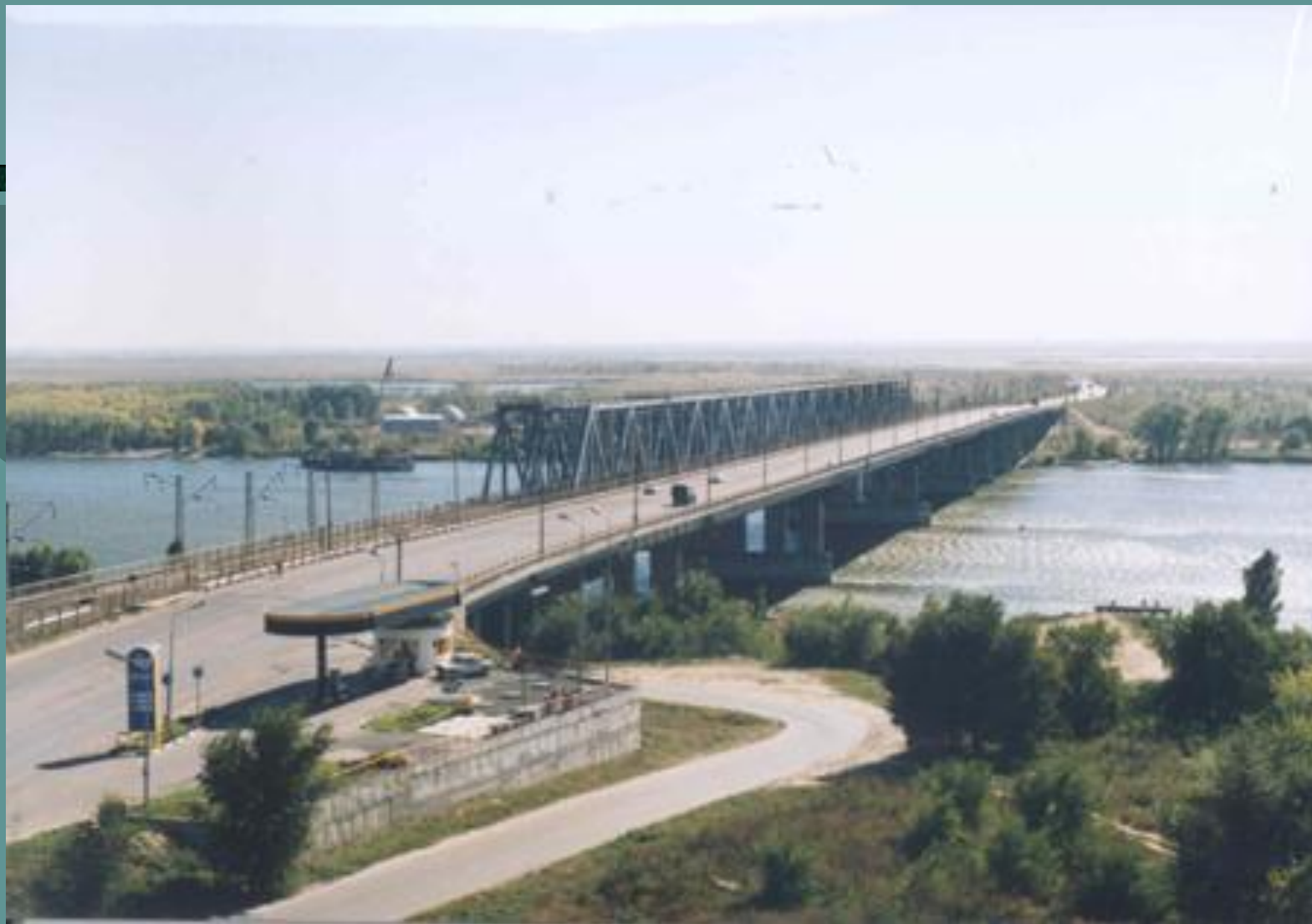
Совмещенный мост через р. Дон на обходе г. Ростова-на-Дону
