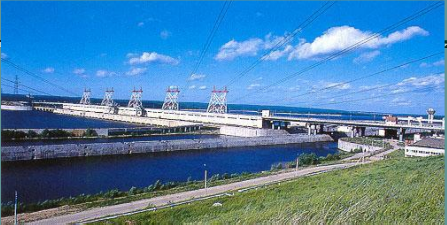
Мост по плотине Чебоксарской ГЭС Год постройки: 1994 г.
