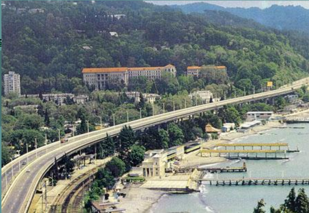
Эстакада в Хосте на автодороге Агура-Адлер Год постройки: 1978 г.
