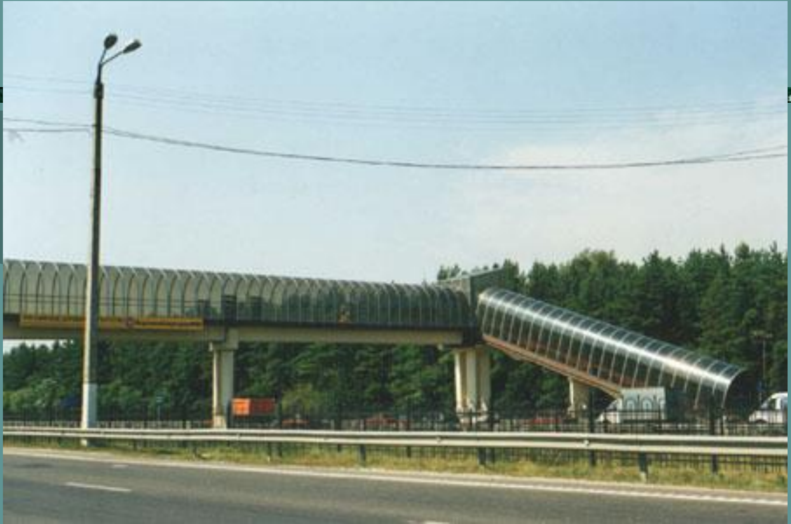
Пешеходный мост на 504 км автодороги
