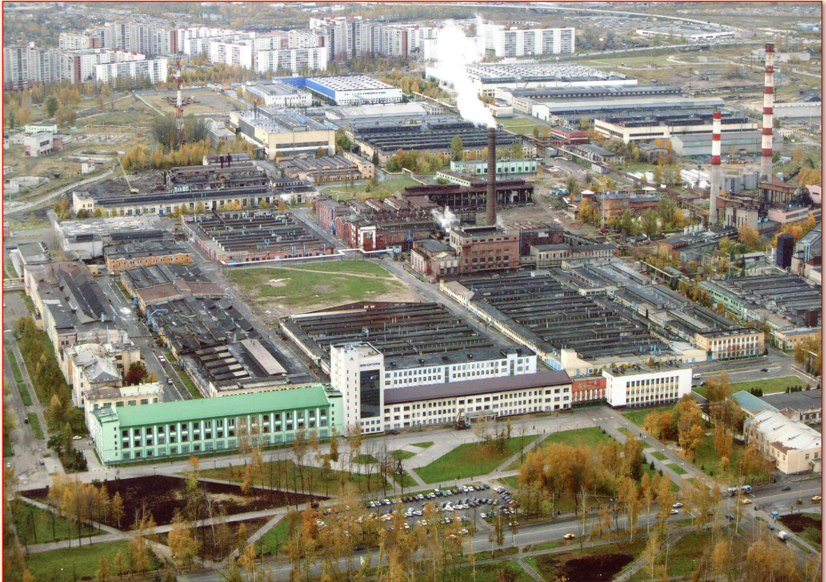
Промплощадка №1 (г. Рыбинск) и микрорайон «Скоморохова гора»
