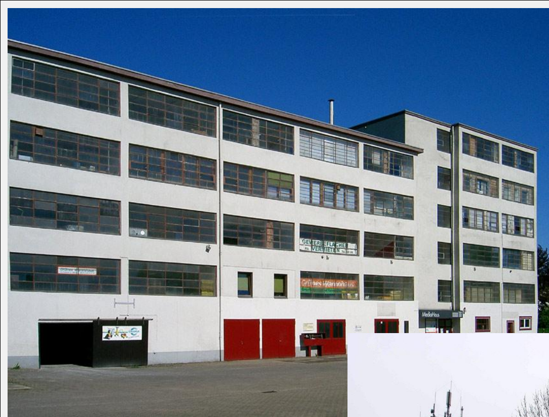
Корпус завода сельскохозяйственной техники «Gebr. Karpe & Co.»
