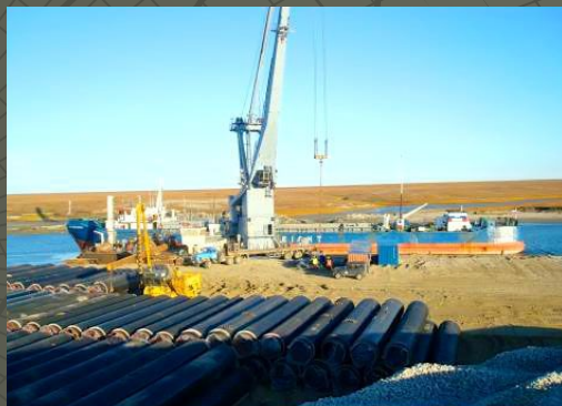
Выгрузка и размещение на береговой площадке труб для строительства т/п
