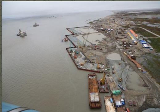
Работа временного причала для обеспечения строительства объектов основного строительства
