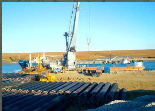
Выгрузка и размещение на береговой площадке труб для строительства т/п
