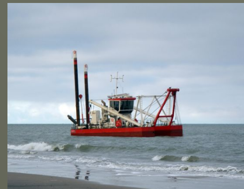
Позиционирование земснаряда на месте работ
