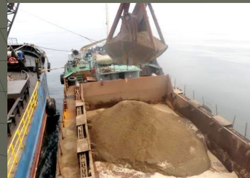
Перегрузка песка с транспортного судна при помощи кранового судна Синекура-1
