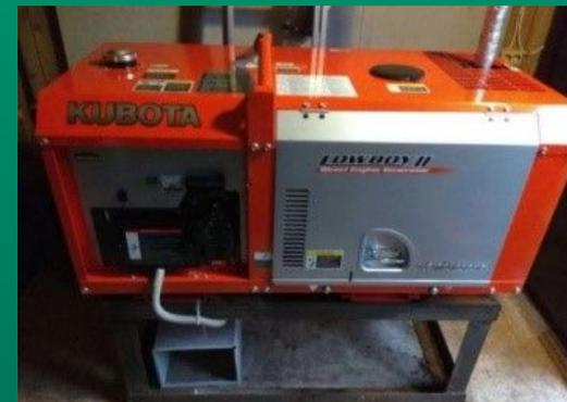
Дизель генератор в кожухе
