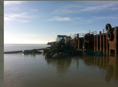
Дноуглубление у причала миниземснарядом
