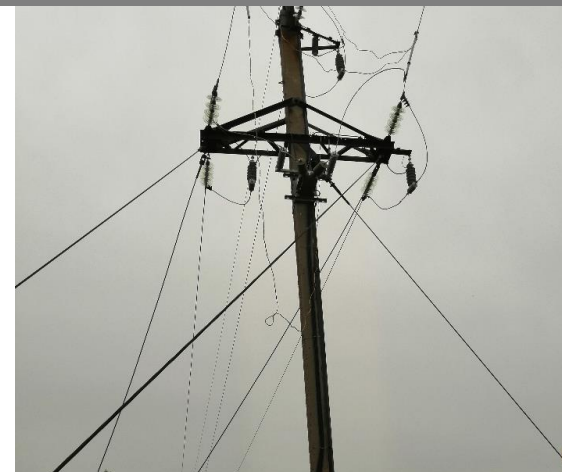
Пункт коммерческого учета 35 кВ для ПАО «МРСК Волги»-«Пензаэнерго»
