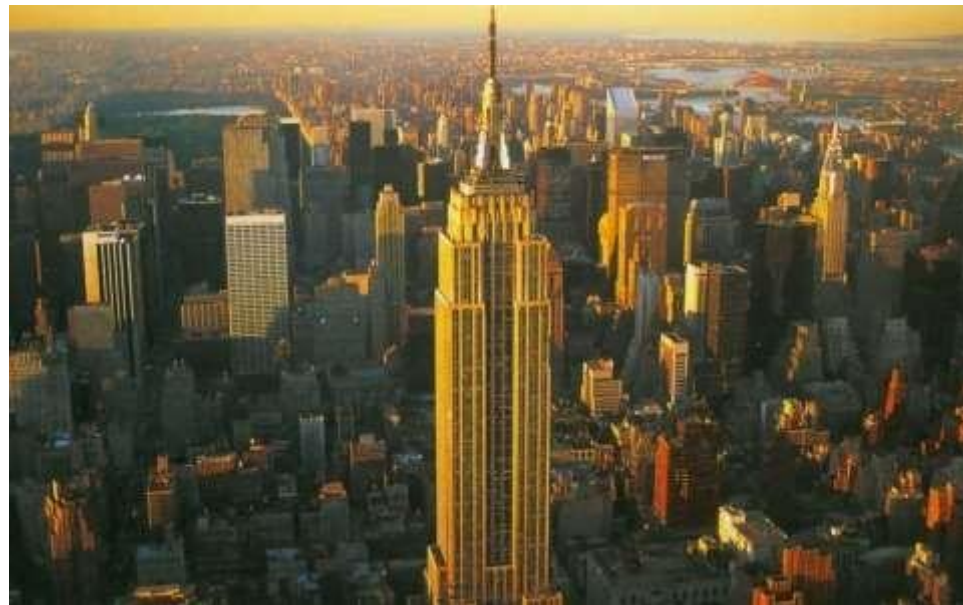
НЕБОСКРЁБ ЭМПАЙР СТЕЙТ БИЛДИНГ
