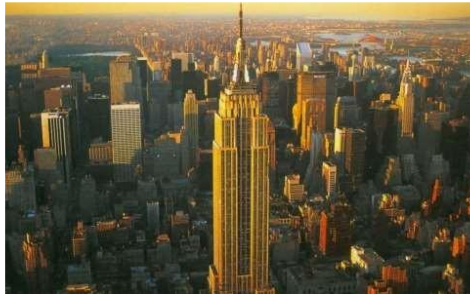
НЕБОСКРЁБ ЭМПАЙР СТЕЙТ БИЛДИНГ
