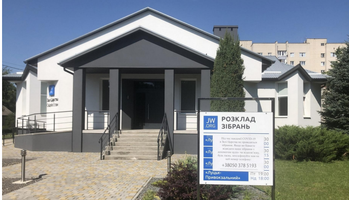
Зал Царства в м. Луцьк, завершення капітального ремонту
