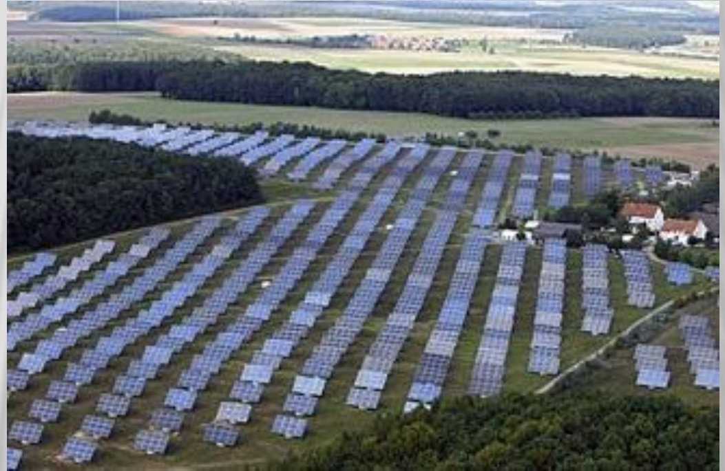
Солнечная электростанция в Германии
