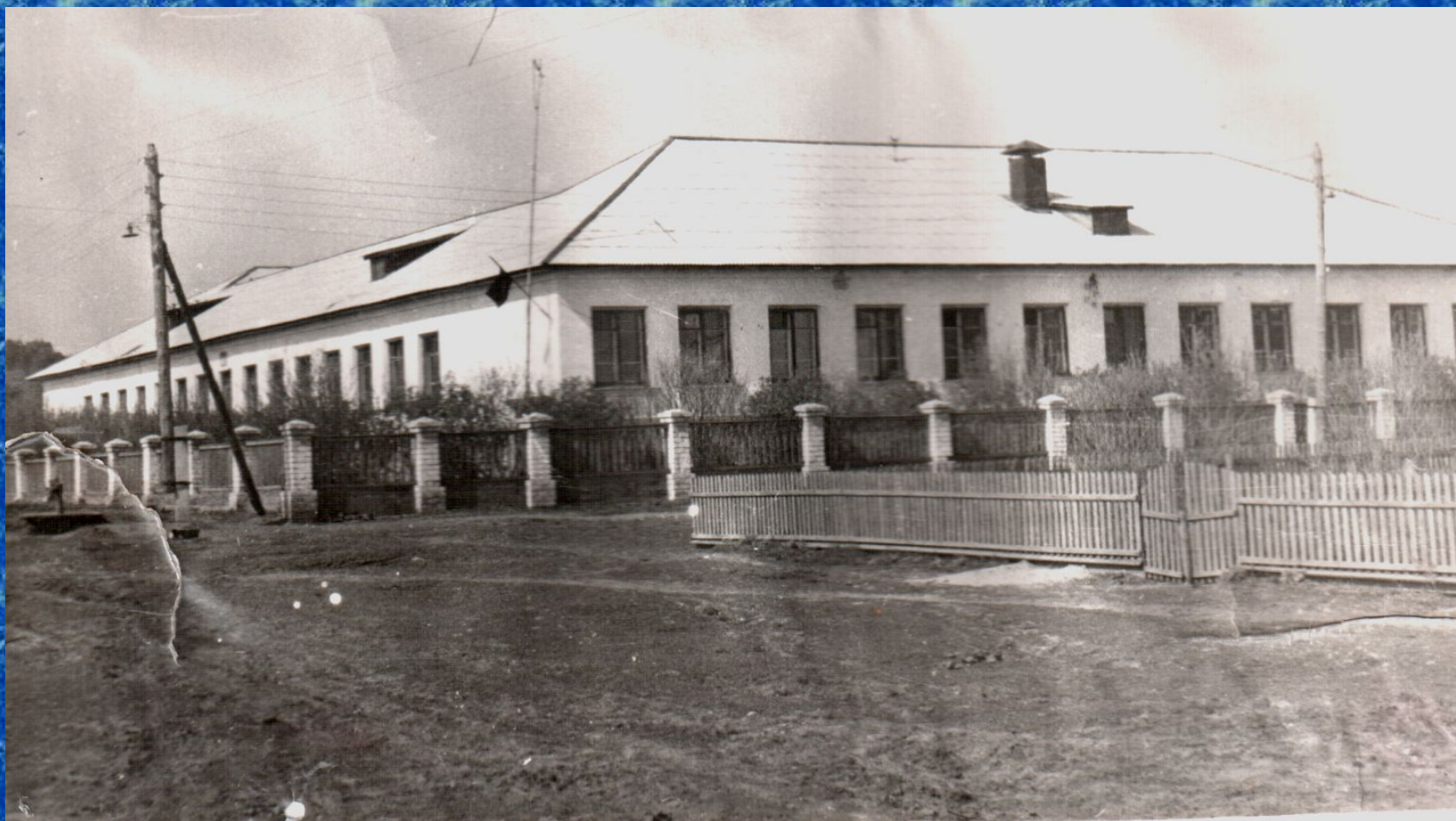
Здание школы. Время постройки - 1964 год
