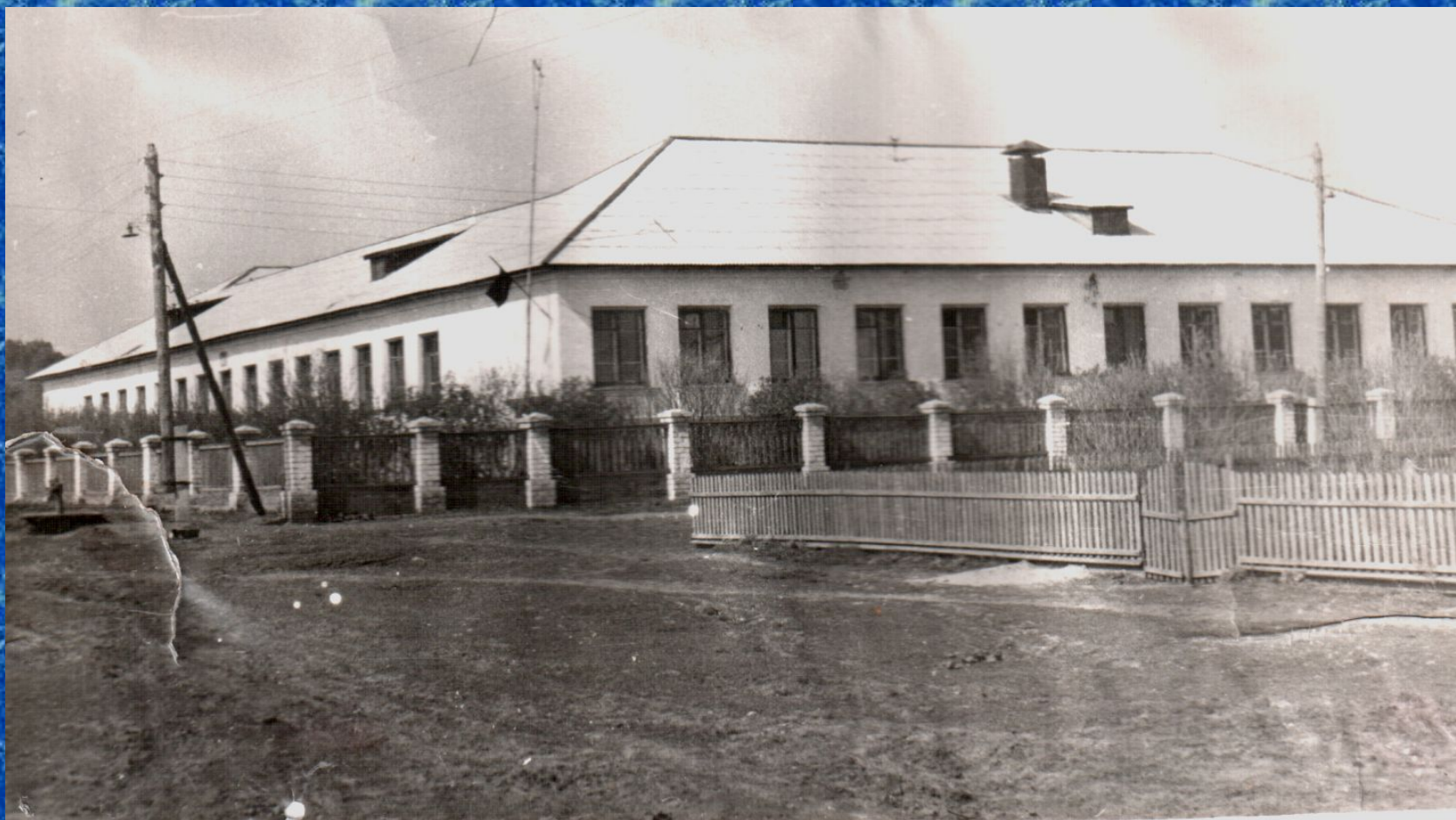
Здание школы. Время постройки - 1964 год
