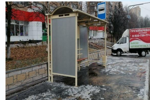
Установка дополнительного остановочного павильона г. Голицыно
