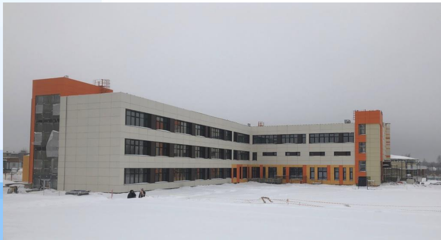
Строительство пристройки на 300 мест к Апрелевской СОШ, 2021
