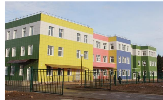
Строительство детского сада № 19 г. Наро-Фоминск (2020)
