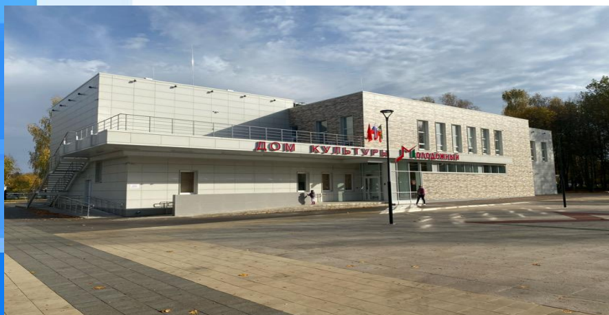
Строительство ДК в п. Молодежный, 2020
