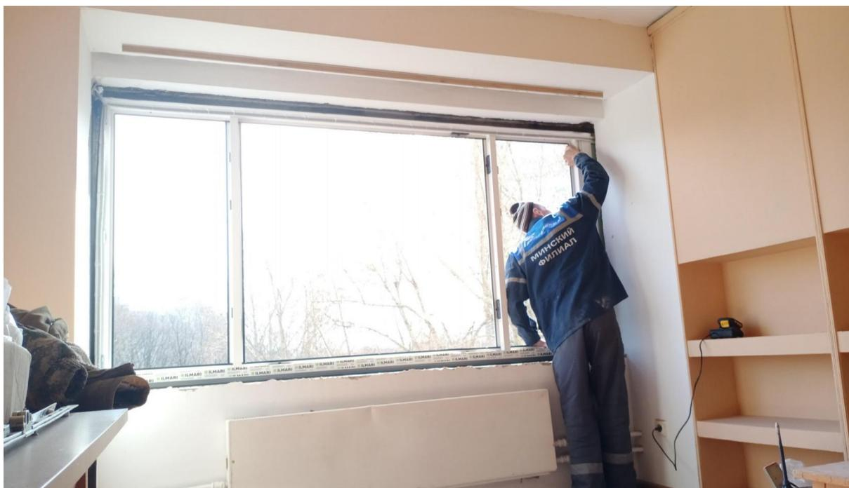
1.4) Установка в жилых и общественных зданиях оконных блоков из ПВХ профилей: поворотных (откидных, поворотно-откидных) с площадью проема более 2 м<sup>2</sup> трехстворчатых, в том числе при наличии створок глухого остекления
