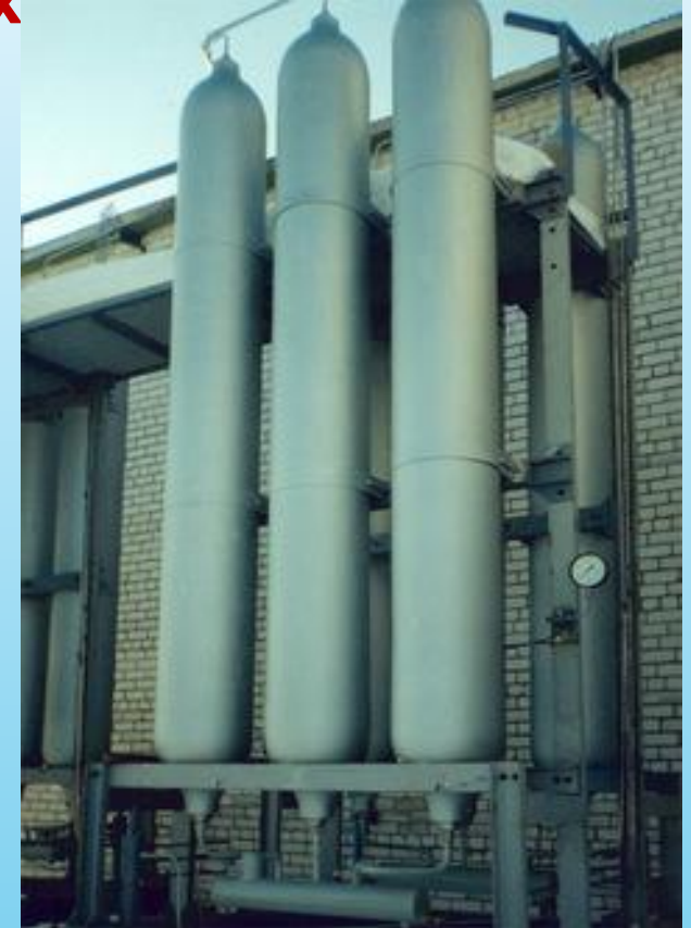
Сосуды (баллоны) высокого давления стальные, объем 500 л
