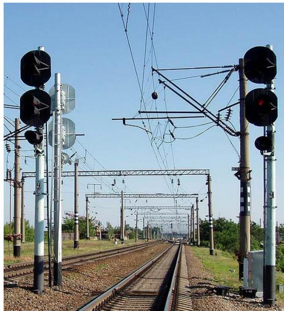
**В качестве постоянных сигнальных приборов применяются – светофоры**
