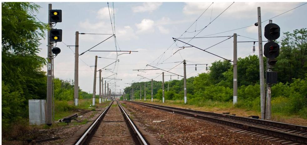
**Входные** **светофоры** располагаются на расстоянии не менее 50 м от острьяк противощерстного и предельного столбика пошерстного входного стрелочного перевода, первого от перегона
