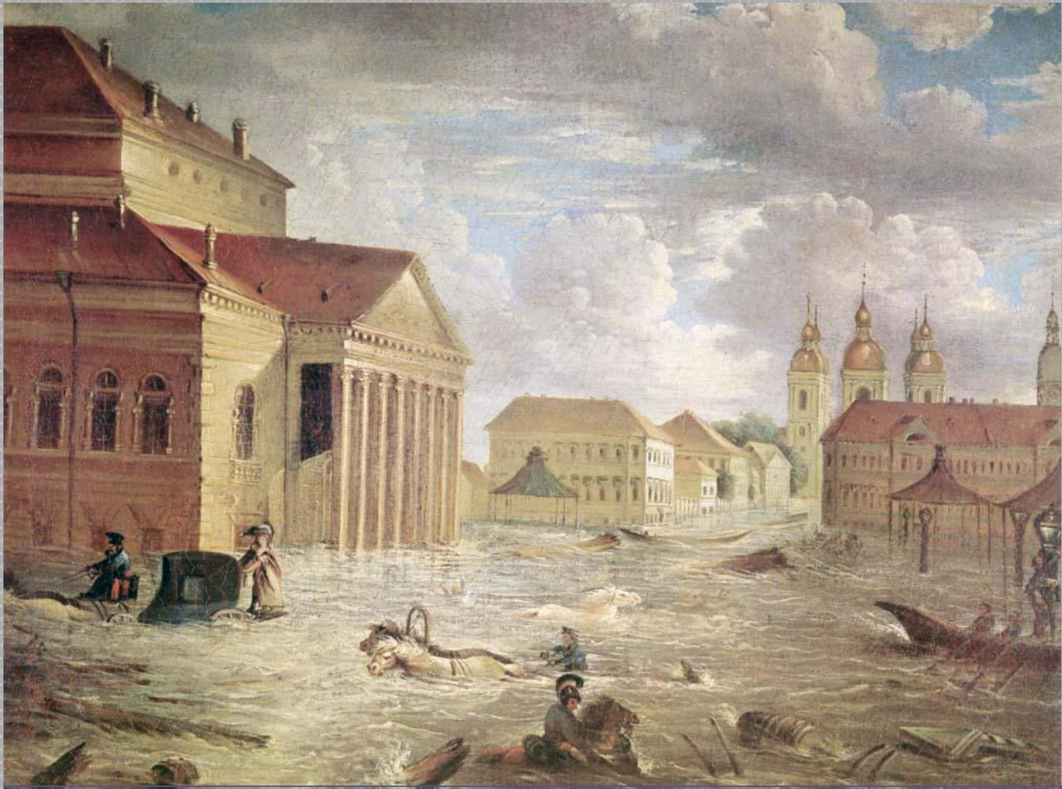
Наводнение в Санкт-Петербурге.
