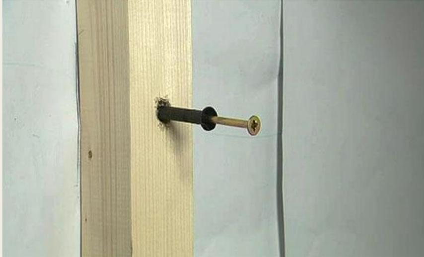
4. Первая направляющая закрепляется у края стены (в углу либо от пола) с помощью дюбелей и саморезов.
