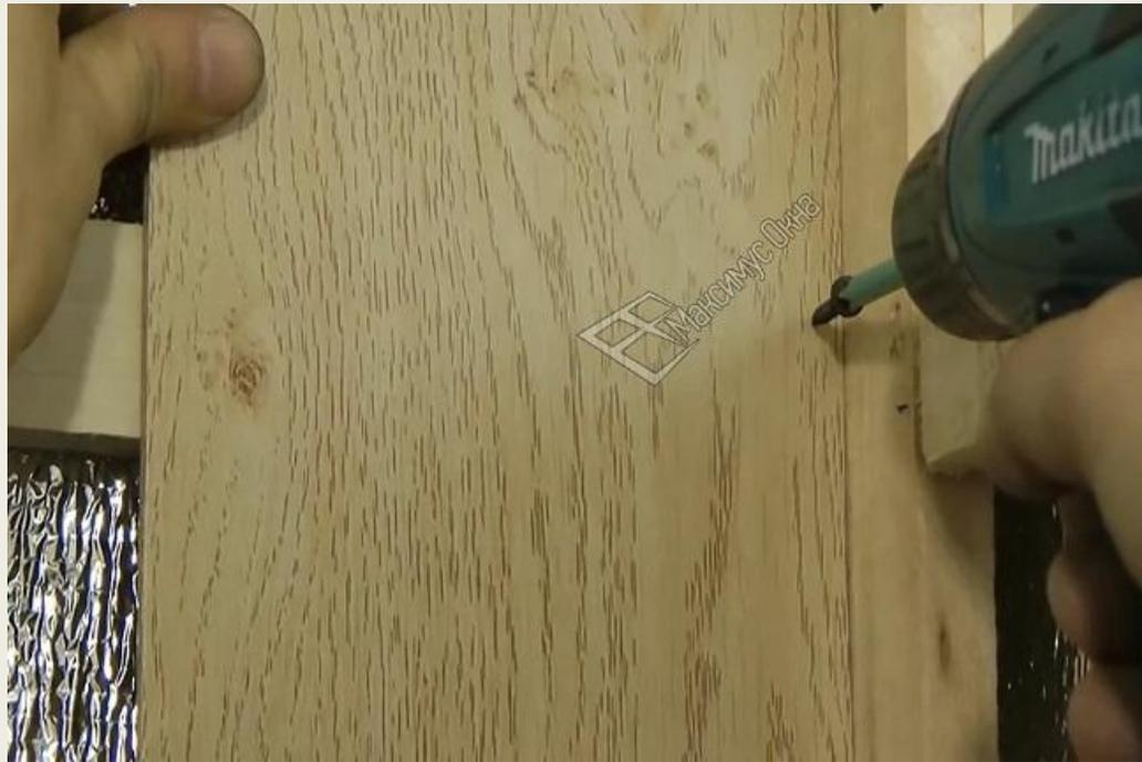
9. Панель крепится к углу стены шипом, закрепляется с этой стороны несколькими саморезами;
