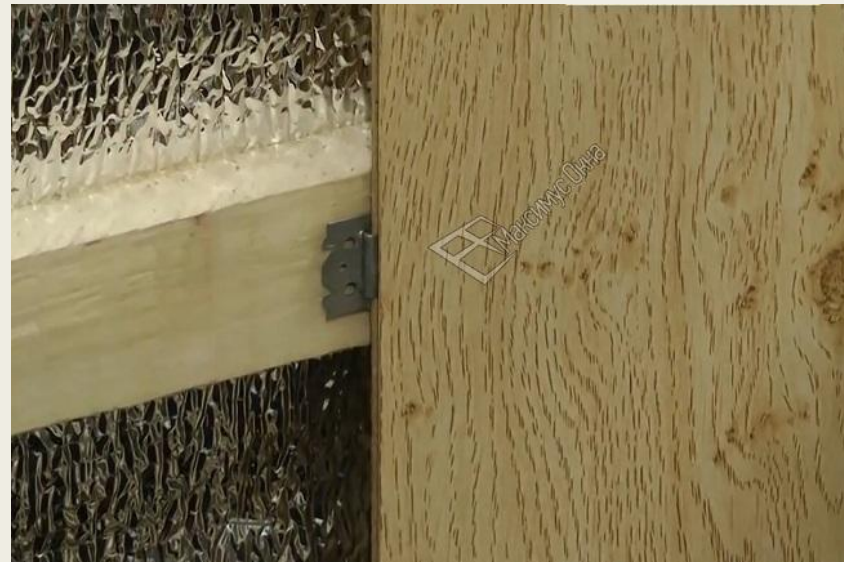
С помощью кляймеров
