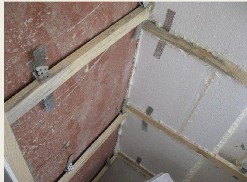
2. На подготовленную стену монтируется обрешетка. Для горизонтальных панелей направляющие каркаса должны быть вертикальными, для вертикальных – горизонтальными;
