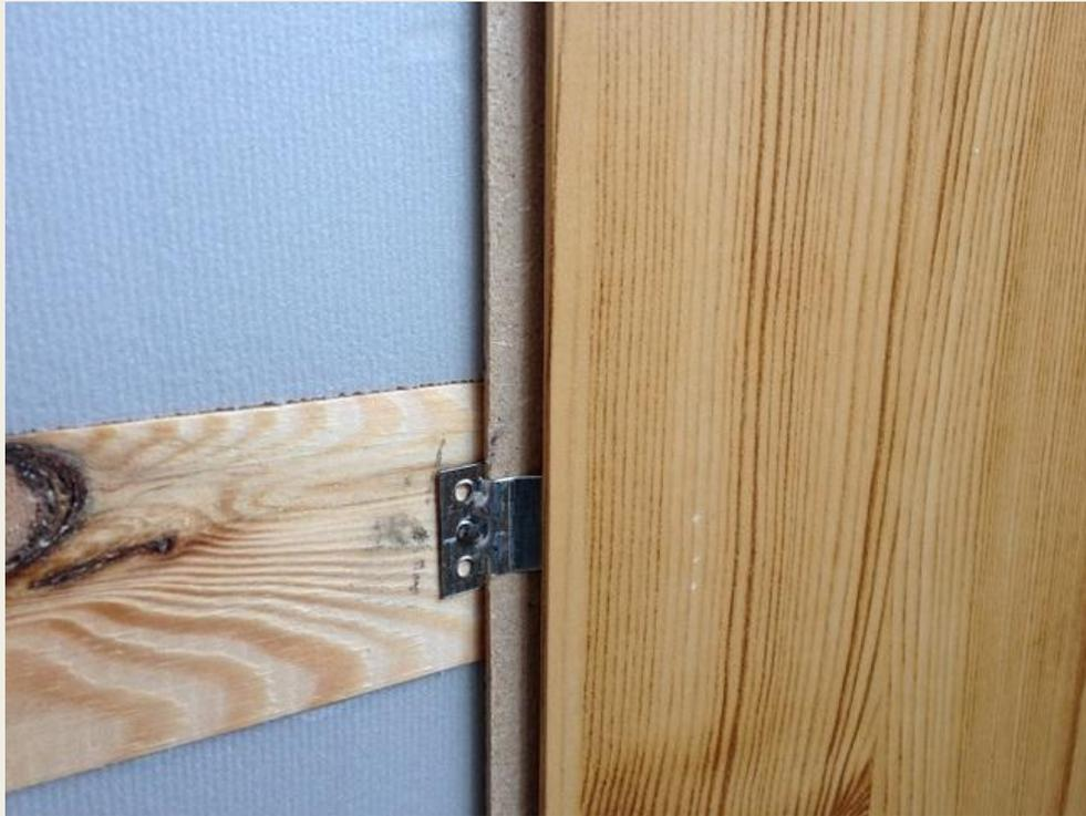
11. Шип следующей панели вставляется в паз предыдущей и сверяется по уровню, чтобы исключить люфт соединения. Паз ее так же закрепляется кляймерами
